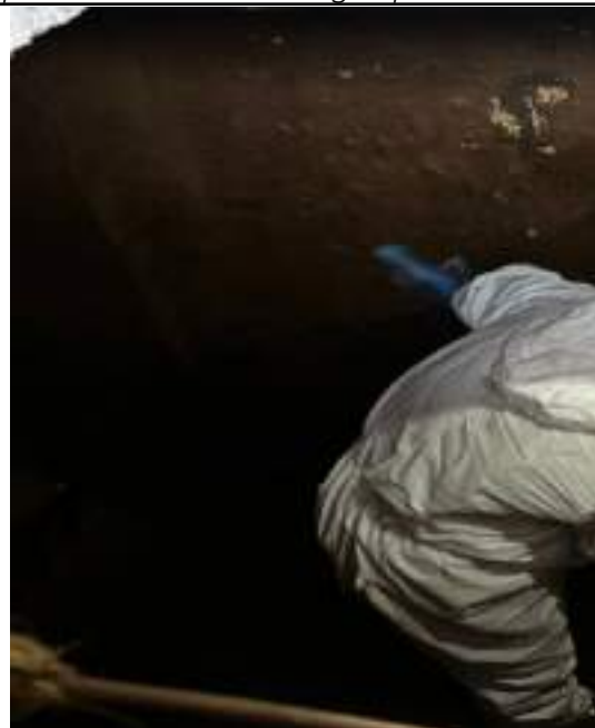
FOTO 28: Higienização dos reservatórios superiores e inferiores de água potável.
