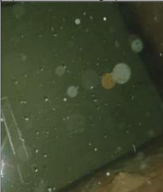
FOTO 27: Higienização dos reservatórios superiores e inferiores de água potável.
