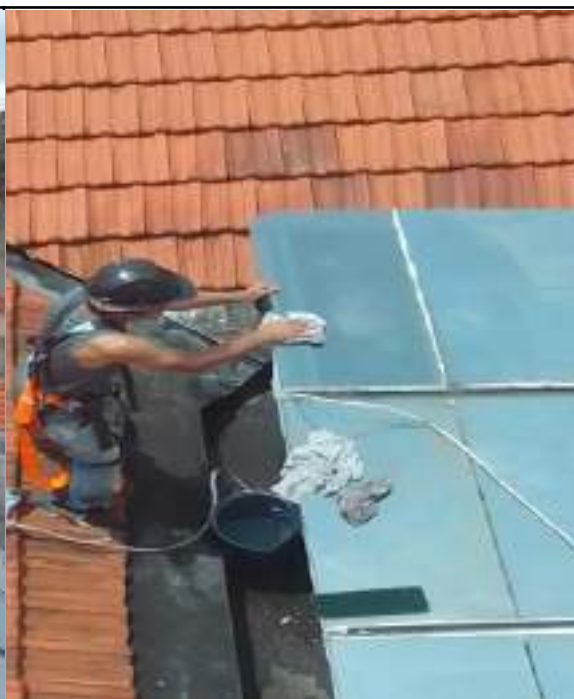
FOTO 48: Iniciado atividade de manutenção corretiva da cobertura de vidro do 3º pavimento para reparação dos vazamentos.
