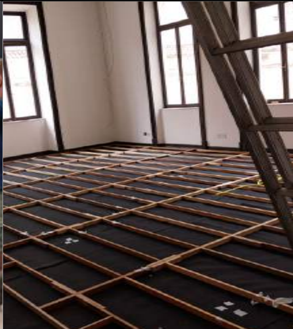
FOTO 80: Montagem auto portante da estrutura das salas expositivas.
