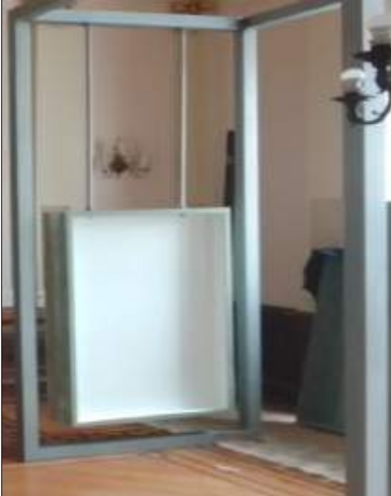
FOTO 77: Montagem auto portante da estrutura das salas expositivas.
