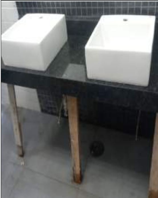
FOTO 69: Manutenção corretiva do conjunto de pias e bancada do sanitário do 3º pavimento.
