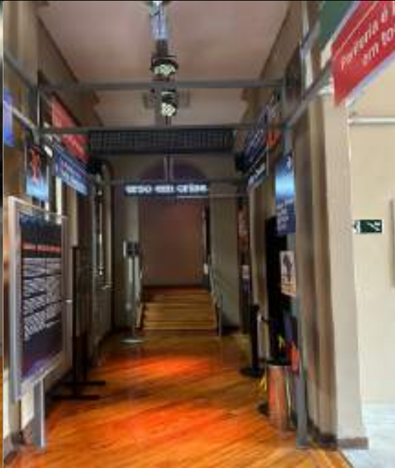
FOTO 104: Montagem auto portante da estrutura das salas expositivas.
