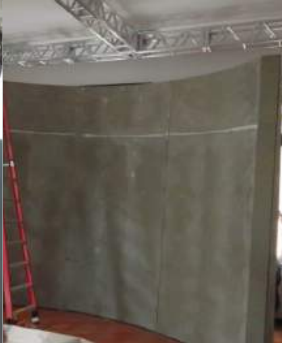
FOTO 78: Montagem auto portante da estrutura das salas expositivas.
