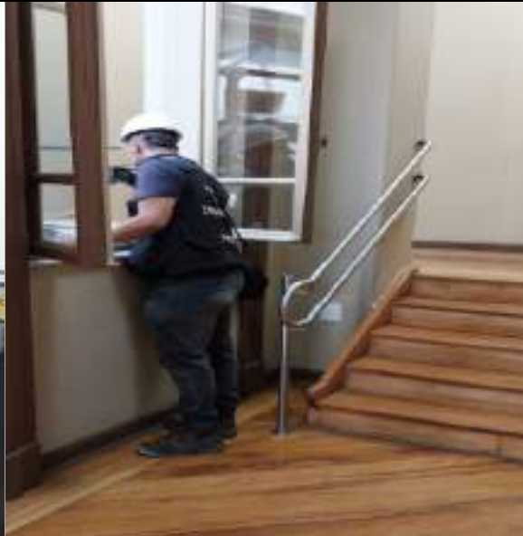
FOTO 54: Serviço técnico especializado para realização de Autovistoria predial das instalações do Museu, conforme especificações da ABNT NBR 16767:2020
