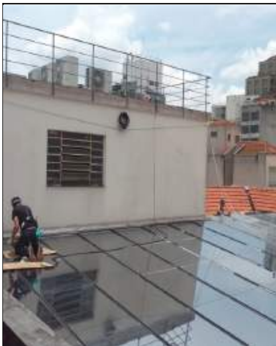
FOTO 47: Iniciado atividade de manutenção corretiva da cobertura de vidro do 3º pavimento para reparação dos vazamentos.
