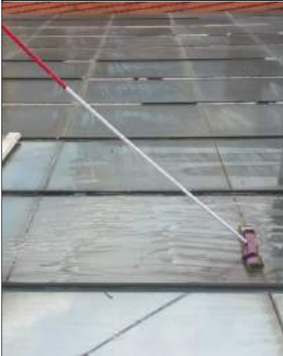
FOTO 43: Iniciado atividade de manutenção corretiva da cobertura de vidro do 3º pavimento para reparação dos vazamentos.
