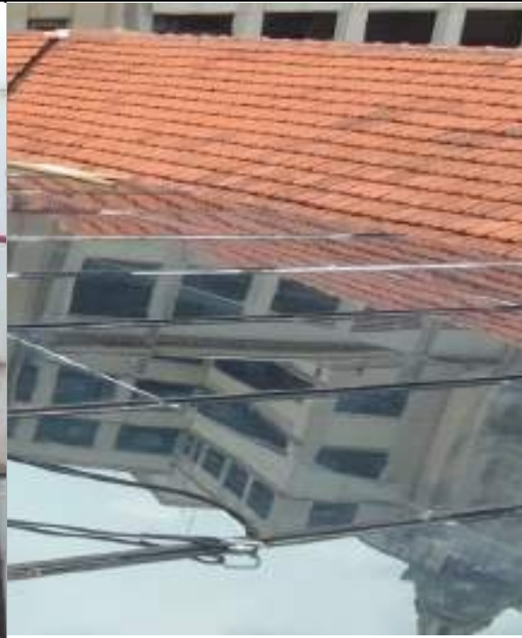
FOTO 46: Iniciado atividade de manutenção corretiva da cobertura de vidro do 3º pavimento para reparação dos vazamentos.
