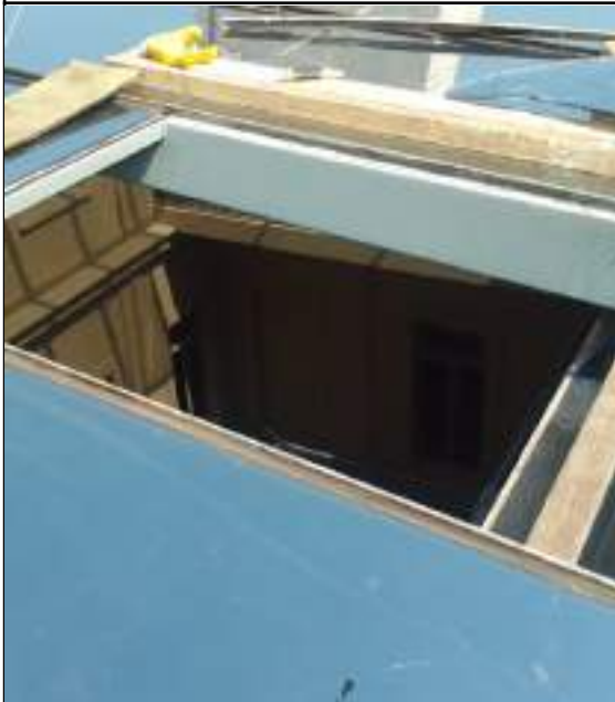
FOTO 49: Iniciado atividade de manutenção corretiva da cobertura de vidro do 3º pavimento para reparação dos vazamentos.
