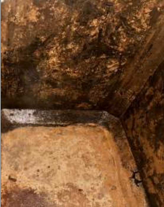
FOTO 31: Higienização dos reservatórios superiores e inferiores de água potável.
