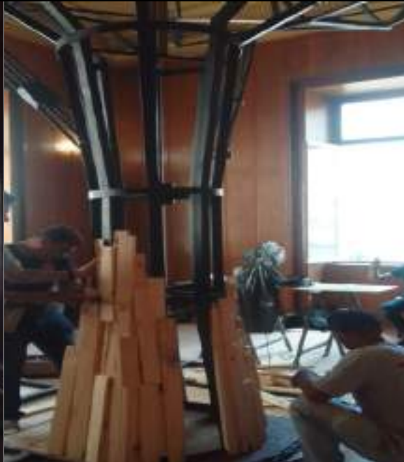
FOTO 82: Montagem auto portante da estrutura das salas expositivas.
