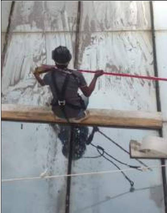
FOTO 45: Iniciado atividade de manutenção corretiva da cobertura de vidro do 3º pavimento para reparação dos vazamentos.
