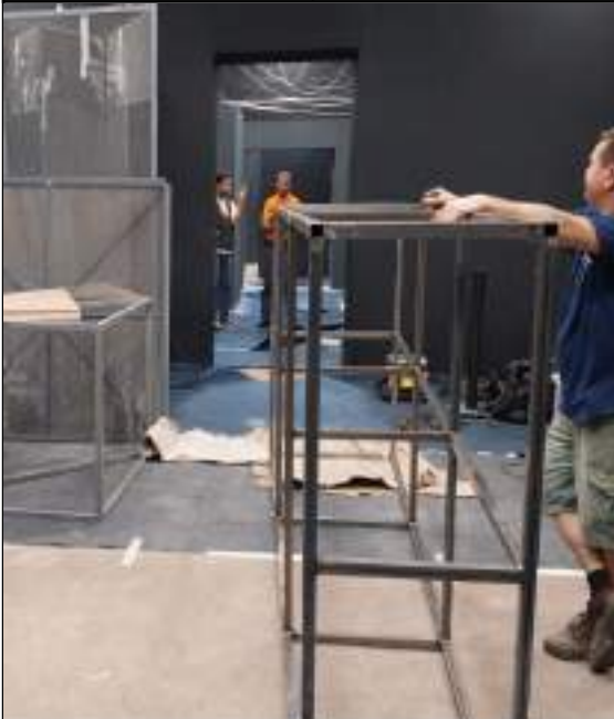
FOTO 79: Montagem auto portante da estrutura das salas expositivas.
