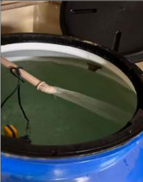
FOTO 25: Higienização dos reservatórios superiores e inferiores de água potável.
