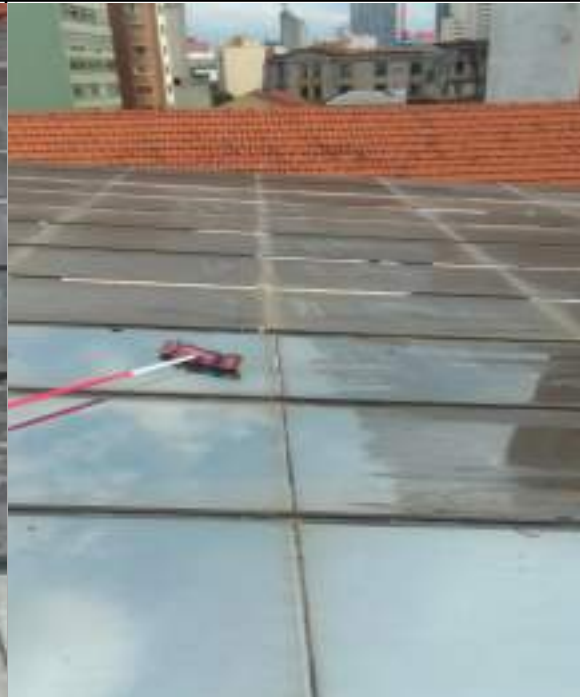
FOTO 44: Iniciado atividade de manutenção corretiva da cobertura de vidro do 3º pavimento para reparação dos vazamentos.
