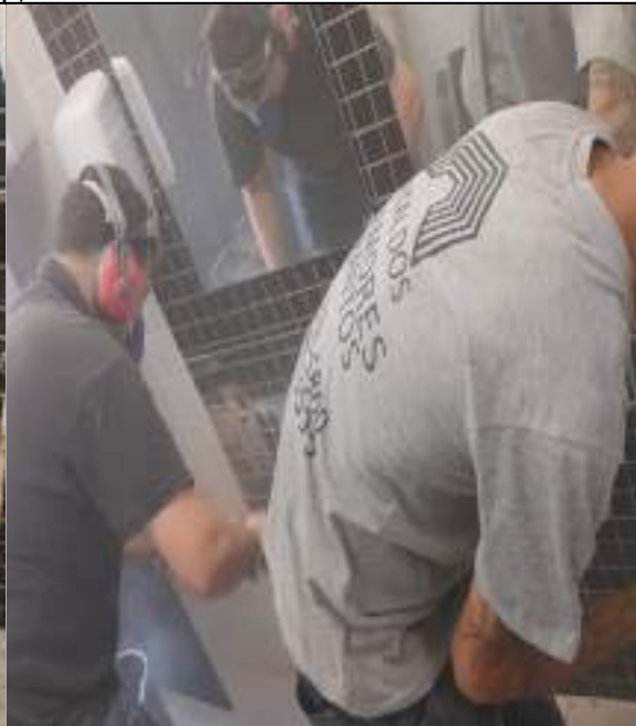
FOTO 66: Manutenção corretiva do conjunto de pias e bancada do sanitário do 3º pavimento.
