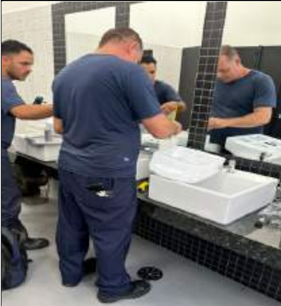
FOTO 33: Higienização dos reservatórios superiores e inferiores de água potável.
