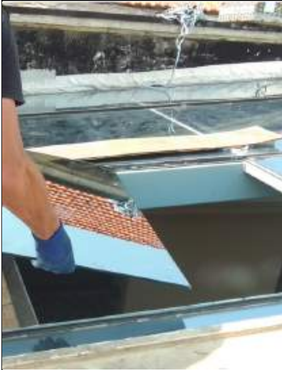
FOTO 49: Iniciado atividade de manutenção corretiva da cobertura de vidro do 3º pavimento para reparação dos vazamentos.
