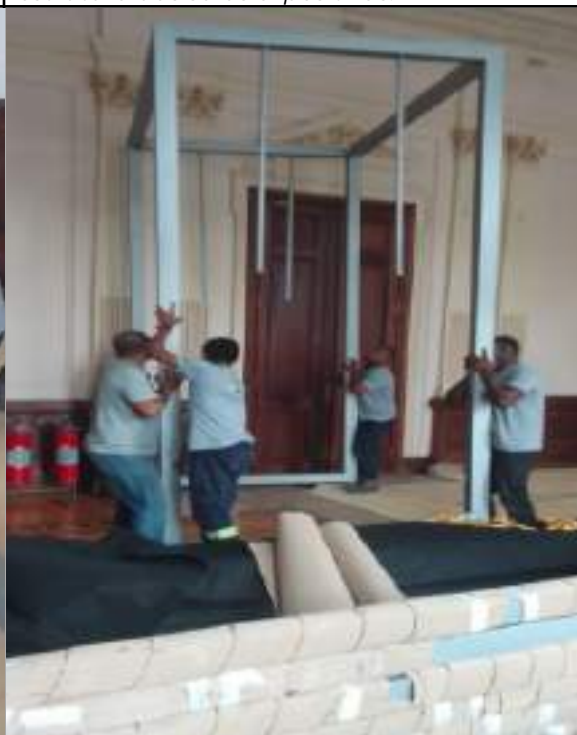
FOTO 76: Montagem auto portante da estrutura das salas expositivas.
