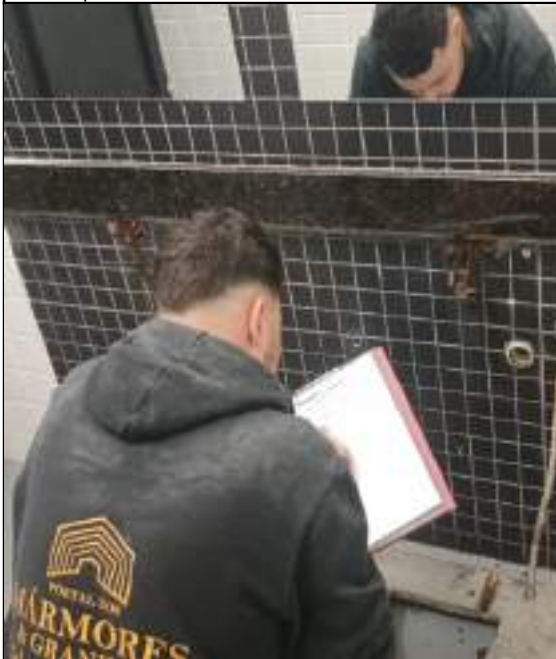
FOTO 65: Manutenção corretiva do conjunto de pias e bancada do sanitário do 3º pavimento.
