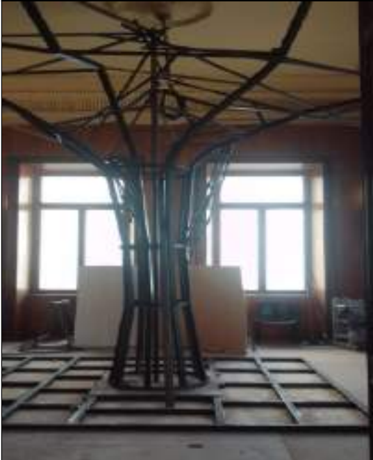
FOTO 81: Montagem auto portante da estrutura das salas expositivas.
