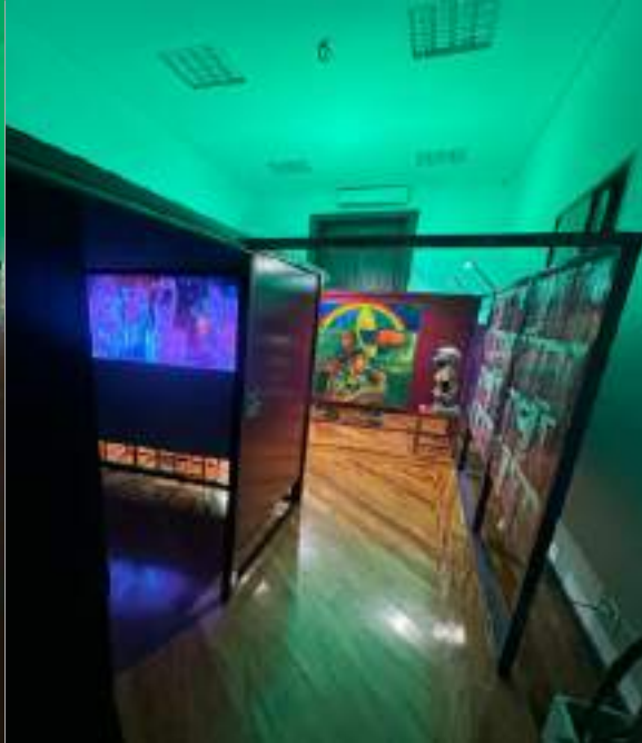
FOTO 102: Montagem auto portante da estrutura das salas expositivas.
