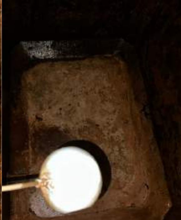
FOTO 32: Higienização dos reservatórios superiores e inferiores de água potável.
