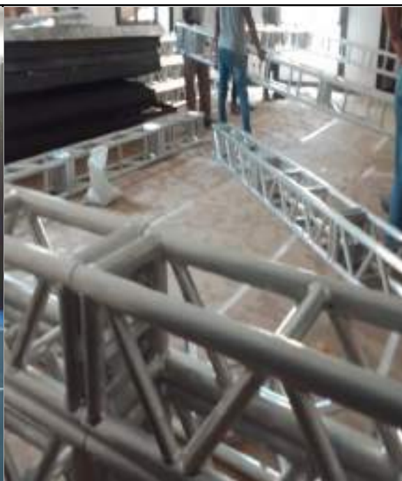
FOTO 76: Montagem auto portante da estrutura das salas expositivas.
