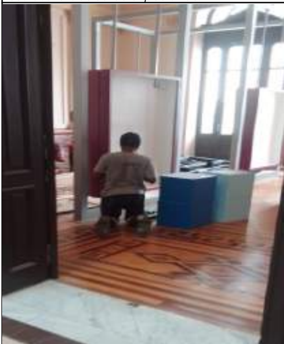
FOTO 89: Montagem auto portante da estrutura das salas expositivas.
