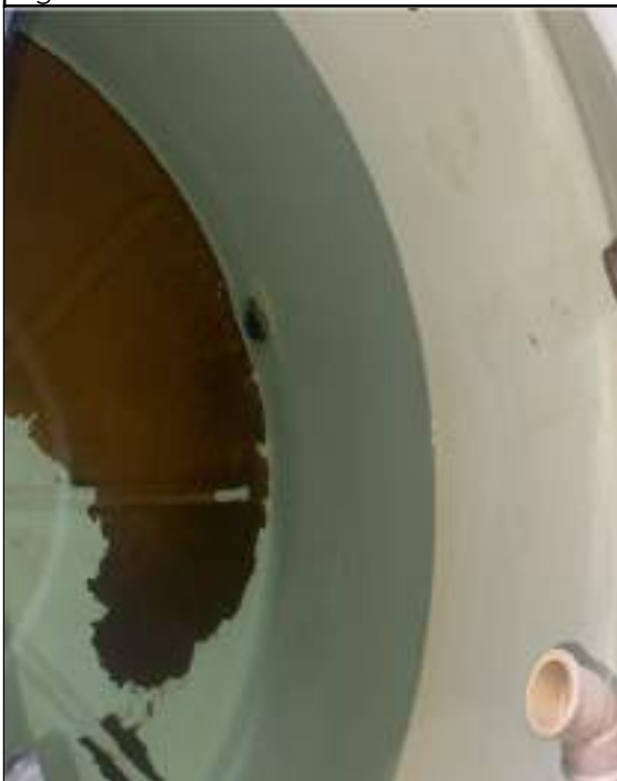
FOTO 21: Higienização dos reservatórios de água.
