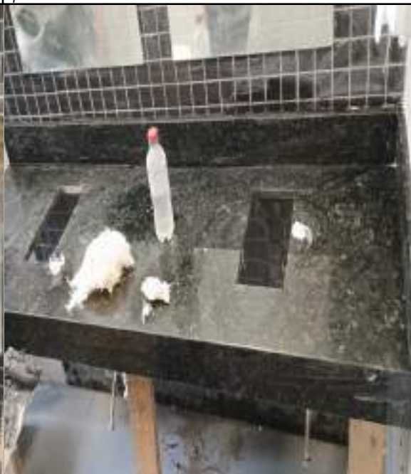
FOTO 68: Manutenção corretiva do conjunto de pias e bancada do sanitário do 3º pavimento.
