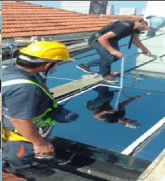
FOTO 50: Iniciado atividade de manutenção corretiva da cobertura de vidro do 3º pavimento para reparação dos vazamentos.
