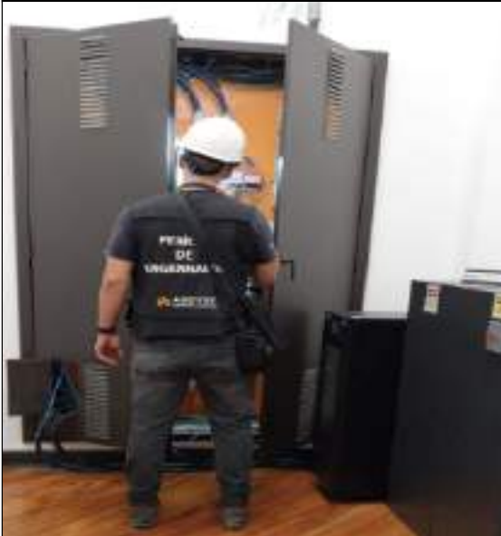
FOTO 53: Serviço técnico especializado para realização de Autovistoria predial das instalações do Museu, conforme especificações da ABNT NBR 16767:2020.
