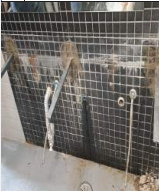
FOTO 67: Manutenção corretiva do conjunto de pias e bancada do sanitário do 3º pavimento.
