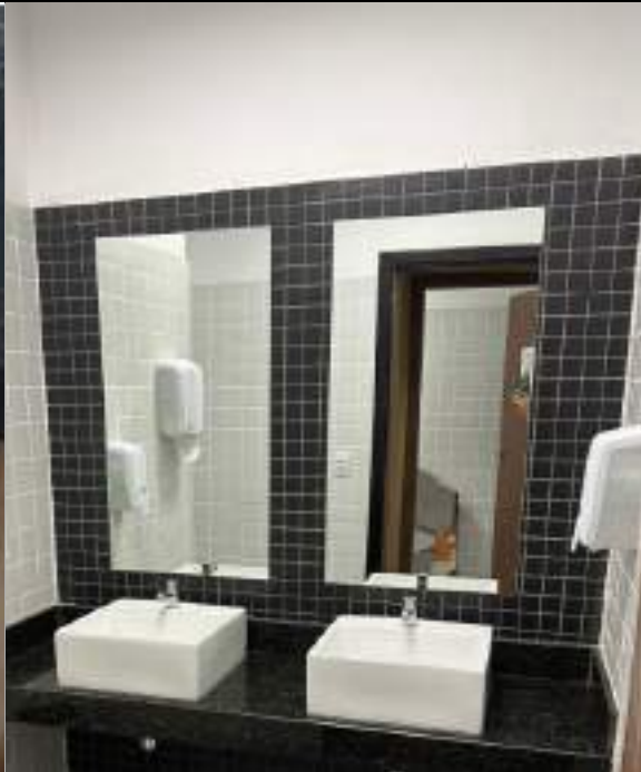
FOTO 70: Manutenção corretiva do conjunto de pias e bancada do sanitário do 3º pavimento.
