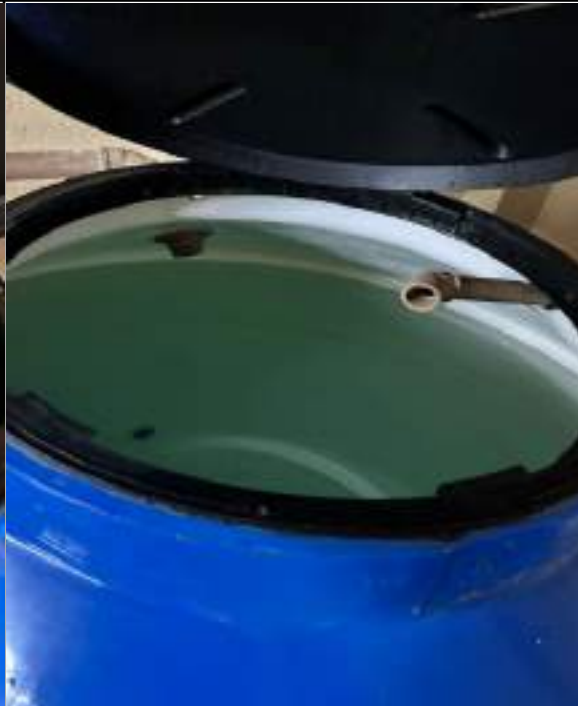
FOTO 26: Higienização dos reservatórios superiores e inferiores de água potável.
