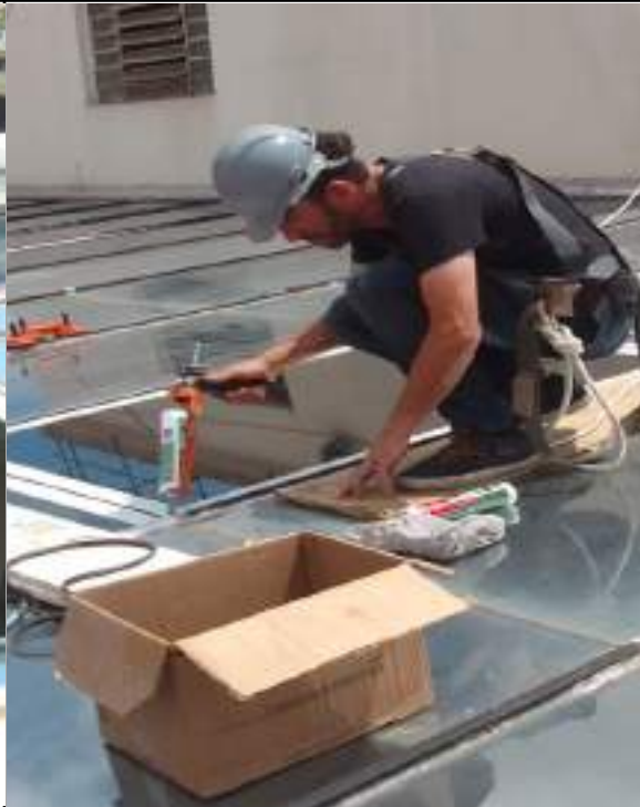
FOTO 50: Iniciado atividade de manutenção corretiva da cobertura de vidro do 3º pavimento para reparação dos vazamentos.
