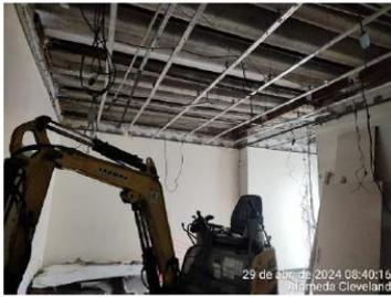
REMOÇÃO DO FORRO ÁREA DE APOIO - ETAPA 1 - EXECUTADO NO DIA 27/04.
