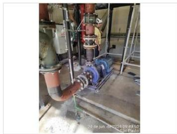
Remanejamento de bomba e interligação de novas tubulações - CAG.
