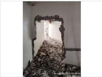
Demolição de alvenarias internas. Pavimento Térreo - Etapa 1.
