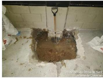
PROSPECÇÃO DA FUNDAÇÃO DO PILAR EIXO 4 - 2ºSS.
