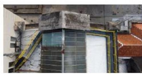
DESCRIÇÃO 8: Remoção/Substituição vidros aramedos - cobertura EA
