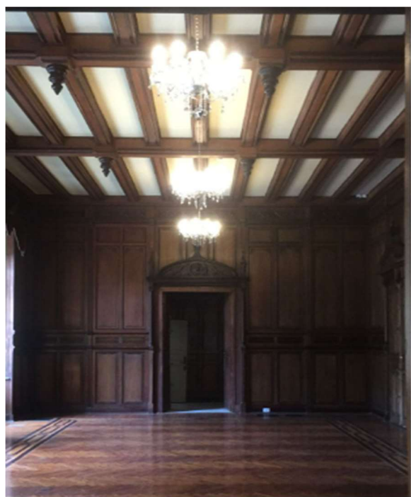
FOTO 9: Conservação sala futura loja, térreo.
