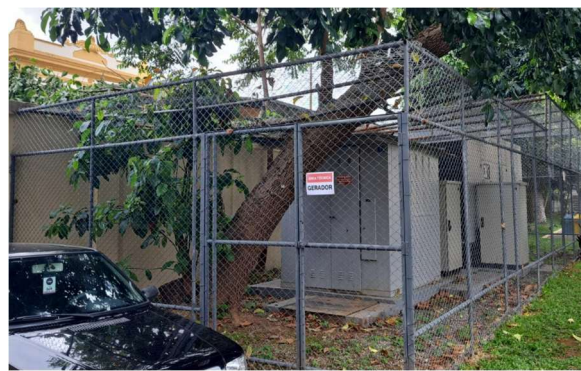
FOTO 116: Manutenção de salas técnicas, revisão da proteção mecânica e pintura, sala trafo e gerador.
