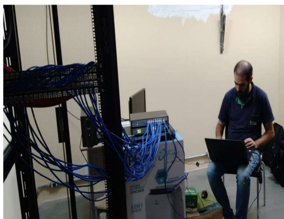
FOTO 71: Implantação CFTV, switch CPD.
