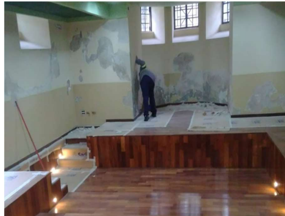
FOTO 82: Manutenção corretiva revestimento paredes auditório.
