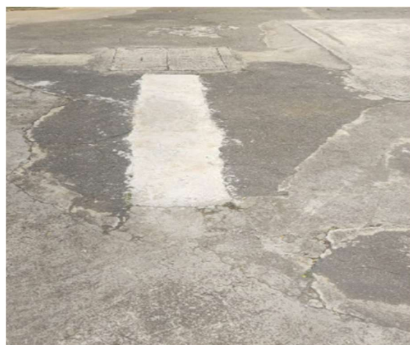
FOTO 102: Conservação revestimento externo de circulação, revestimento com elemento de demarcação, pintura e correção viária.
