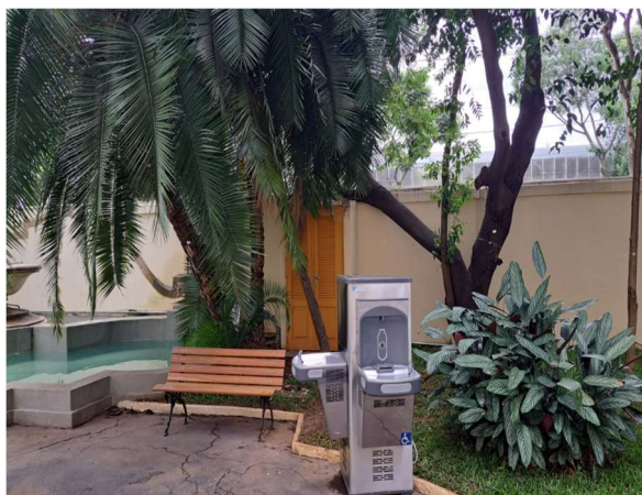
FOTO 111: Implantação de bebedouro acessível.
