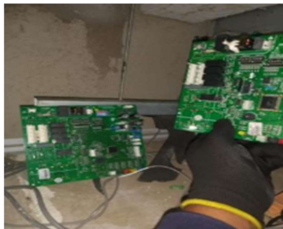
FOTO 28: Reparação segunda etapa após operação sistema de climatização, evaporadora térreo.
