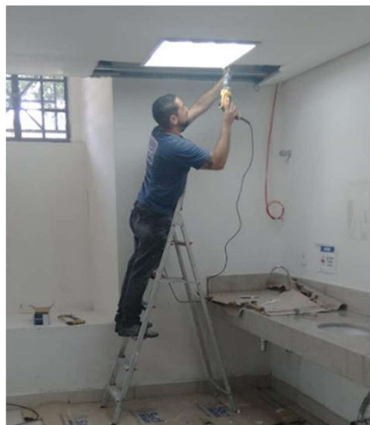
FOTO 58: Adequação forro dry wall área técnica pavimento inferior.
