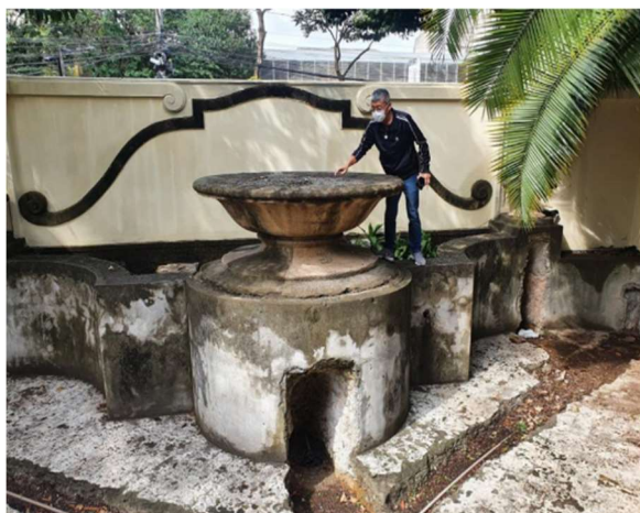
FOTO 61: Recuperação e operação chafariz.
