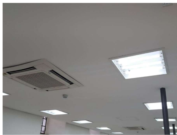
FOTO 60: Conservação, pintura forro e áreas técnicas.
