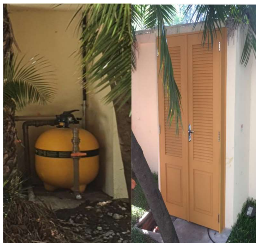
FOTO 64: Recuperação e operação chafariz, implantação de equipamentos para tratamento da água para recirculação e filtragem.
