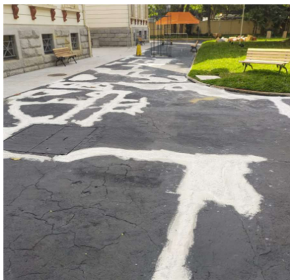
FOTO 99: Conservação revestimento externo de circulação, revestimento com elemento de demarcação, pintura e correção viária.
