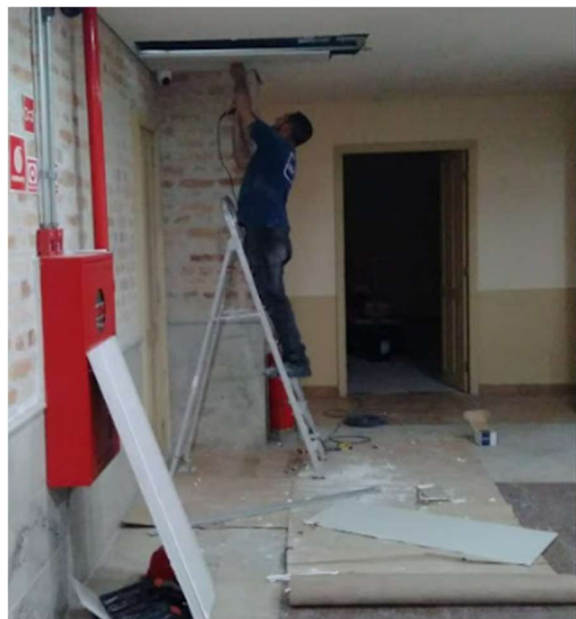
FOTO 57: Adequação forro dry wall hall banheiros pavimento inferior.
