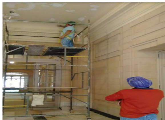
FOTO 6: Conservação forro hall, pavimento térreo.
