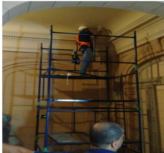
FOTO 68: Implantação CFTV, instalação nos pontos com acessos pré existentes, hall.
