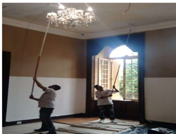
FOTO 31: Reparação forro de drywall, sala biblioteca, térreo.
