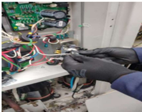
FOTO 27: Reparação segunda etapa após operação sistema de climatização, condensadoras.
