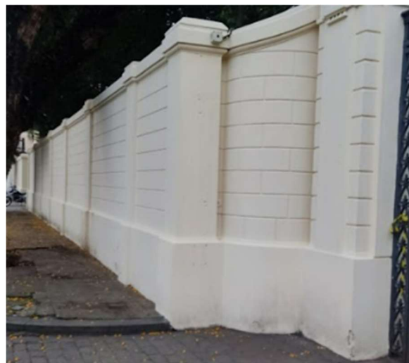
FOTO 20: Conservação muros perimetrais, Rua Guaianazes, antigo ponto de descarte de resíduos, após atividade de conservação.
