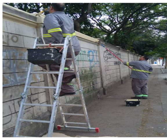
FOTO 18: Conservação muros perimetrais, lateral Alameda Gleite.
