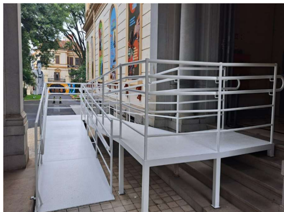
FOTO 110: Pintura e conservação da rampa acessível lateral.
