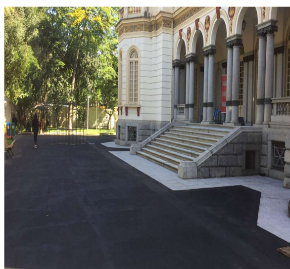
FOTO 108: Conservação revestimento externo de circulação, revestimento com elemento de demarcação, pintura e correção viária.
