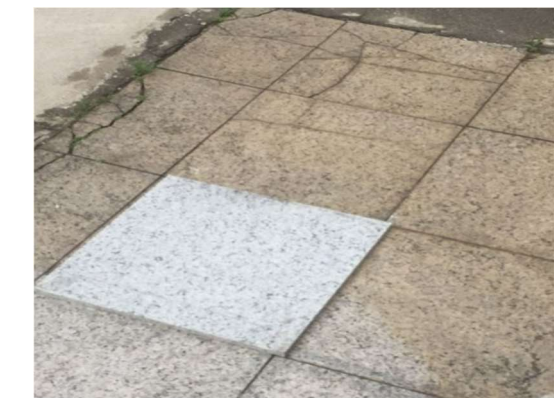
FOTO 51: Conservação revestimento perimetral da área construída, granito flameado.
