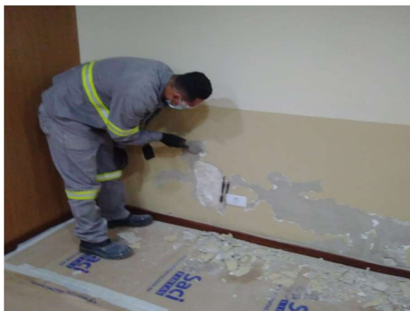
FOTO 81: Manutenção corretiva revestimento paredes auditório.
