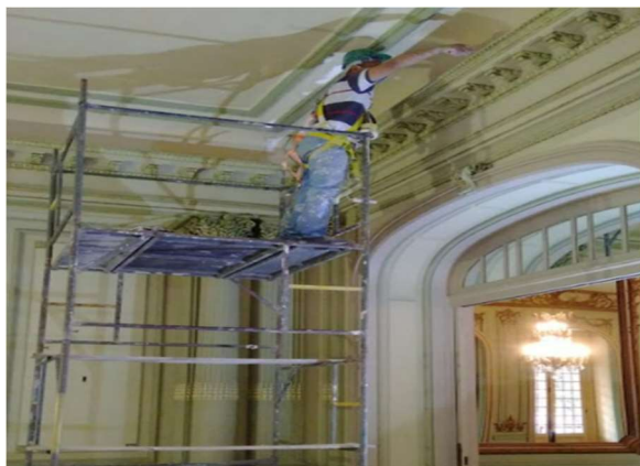
FOTO 7: Conservação forro hall, pavimento térreo
