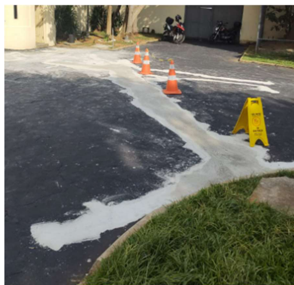
FOTO 100: Conservação revestimento externo de circulação, revestimento com elemento de demarcação, pintura e correção viária.
