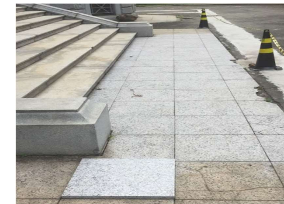
FOTO 52: Conservação revestimento perimetral da área construída, granito flameado.
