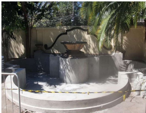
FOTO 65: Recuperação e operação chafariz.
