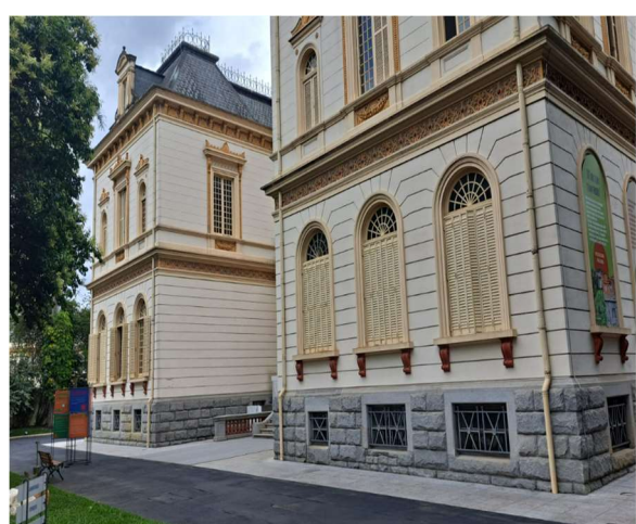
FOTO 56: Conservação revestimento perimetral da área construída, granito flameado.
