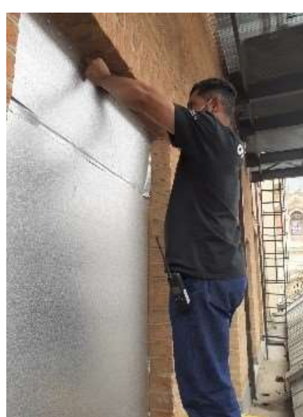
Vedação das janelas com placas de MPU e silicone, para controle térmico
