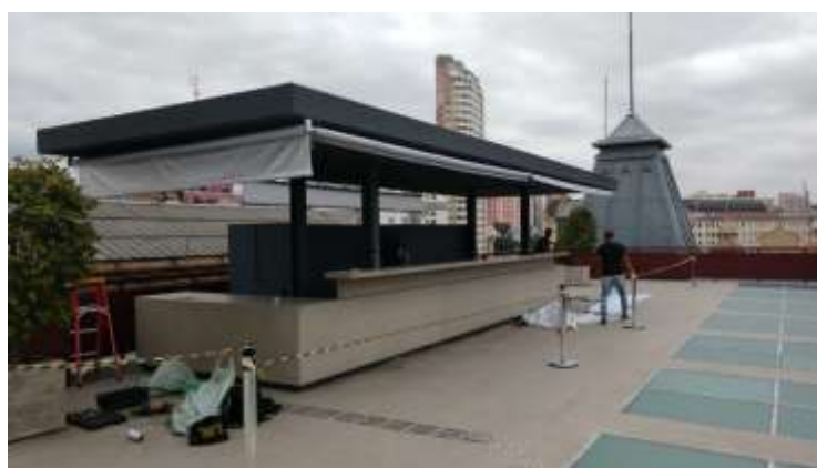
Instalação de proteção no quiosque do terraço
