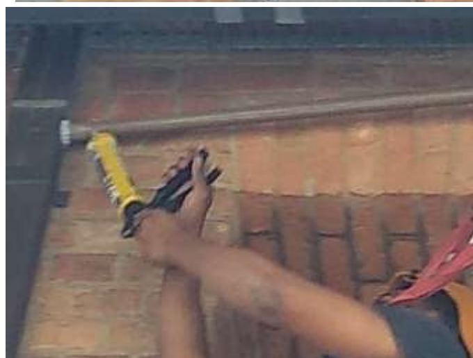
Instalação de sifão no sistema de drenagem de água, para aumentar a vazão, e automaticamente diminuindo a umidade interna do equipamento
