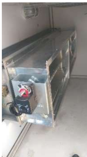
Instalação de damper motorizado com controle de horário para controle climático da sala nos períodos noturnos e diurnos
