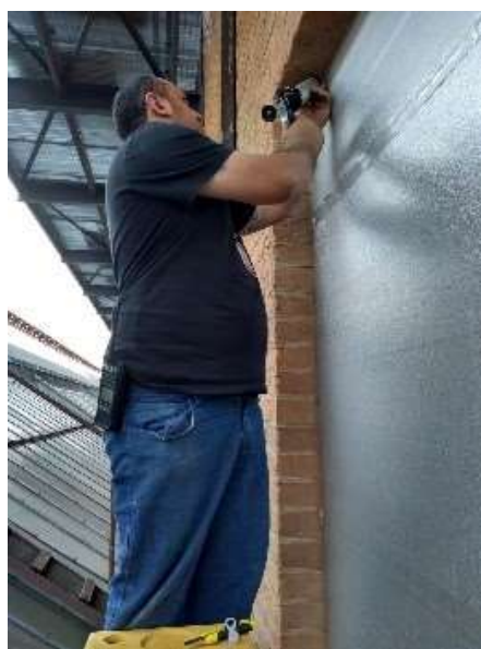
Vedação das janelas com placas de MPU e silicone, para controle térmico
