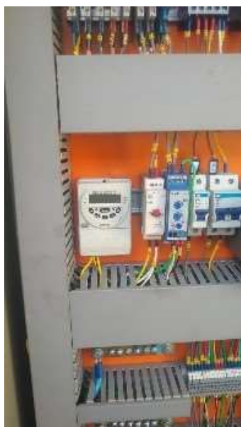
Instalação de damper motorizado com controle de horário para controle climático da sala nos períodos noturnos e diurnos
