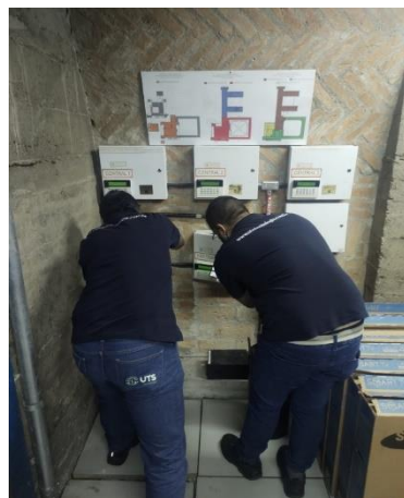
Manutenção no sistema central de alarme contra incêndios
