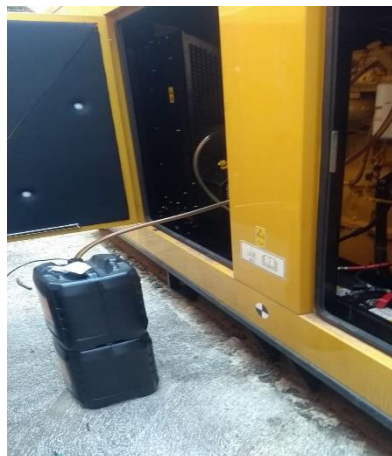
Manutenção dos geradores
