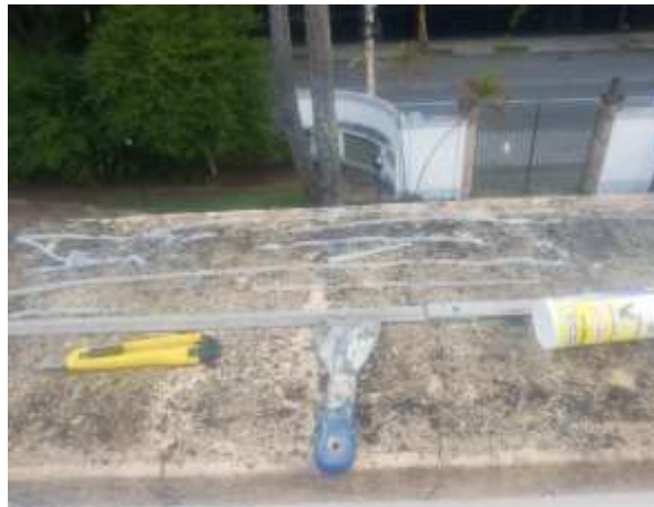
Aplicação de gel repelente contra pombos
