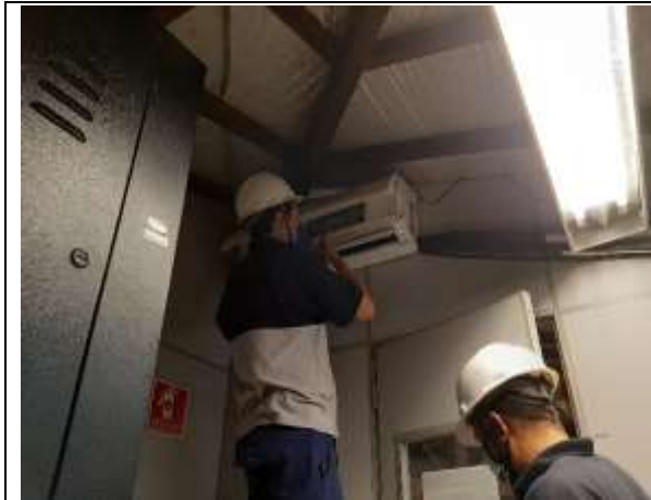
Manutenção Preventiva – Ar Condicionado (Mensal)
