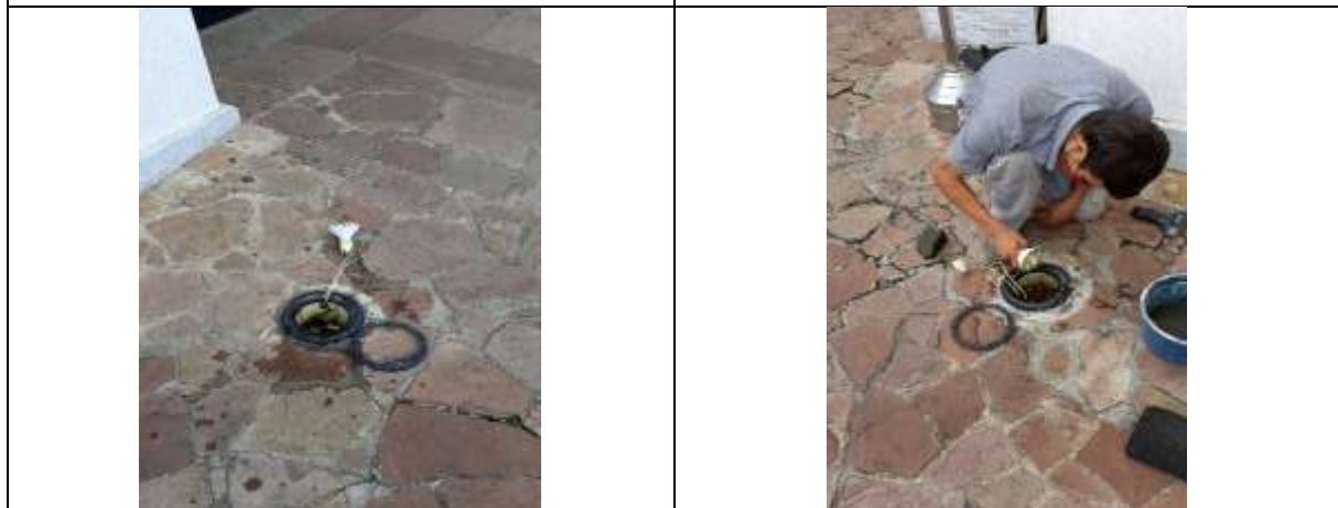
Manutenção das luminárias da fachada
