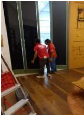
Substituição de vidros danificados
