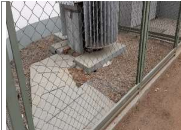
Limpeza da área destinada a Cabine primária
