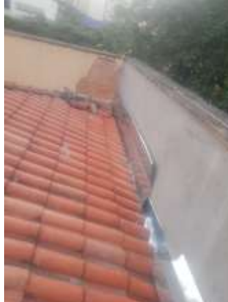
Manutenção corretiva das calhas e platibandas
