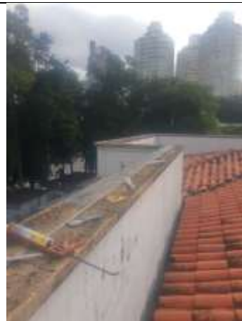
Aplicação de gel repelente contra pombos
