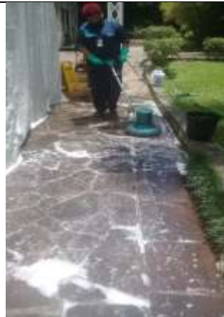
Lavagem – Piso do pátio lateral
