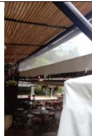
Ajuste na lona da cobertura do Deck do Restaurante
