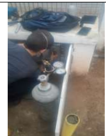
Teste de estanqueidade das tubulações de gás
