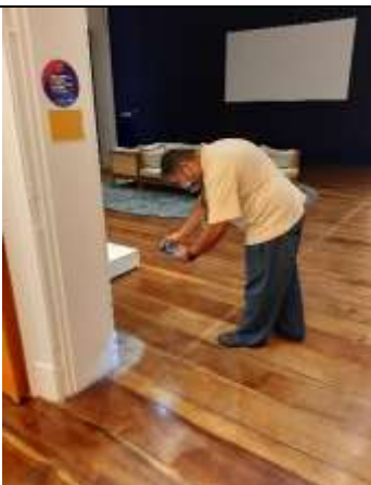
Vistoria trimestral de possíveis focos de cupim – Controle de Pragas (Trimestral)
