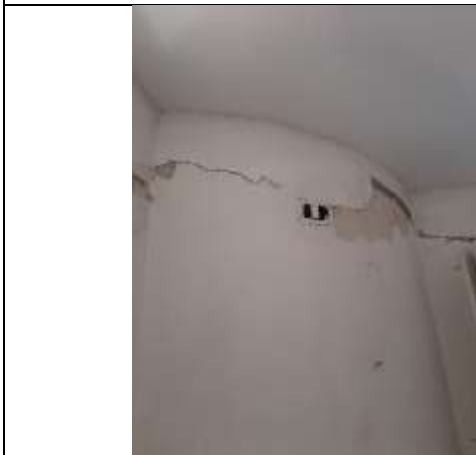
Pintura e recuperação – Guarita
