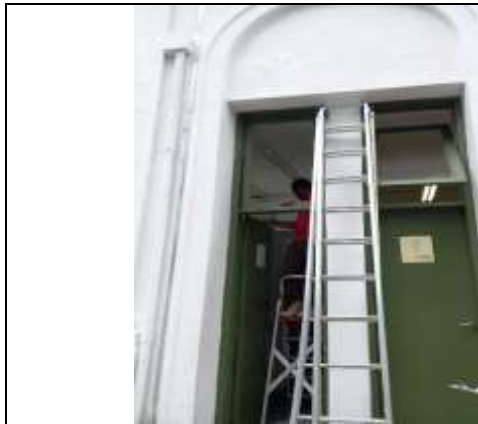
Substituição de vidros danificados
