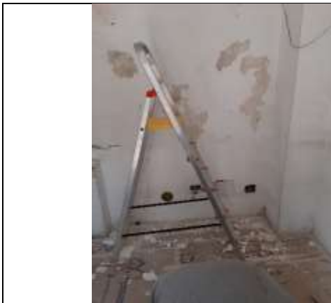
Pintura e recuperação - Guarita
