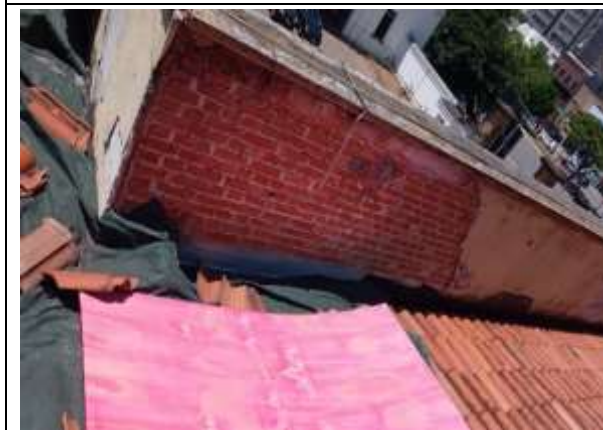
Manutenção corretiva das calhas e platibandas
