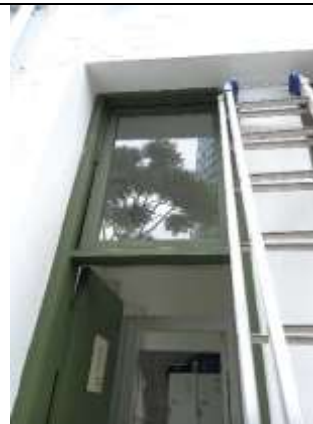
Substituição de vidros danificados
