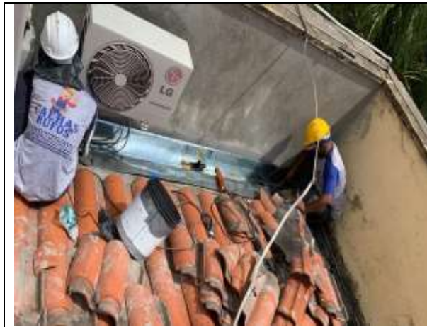
Manutenção corretiva das calhas e platibandas
