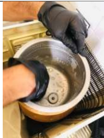
Higienização semestral dos bebedouros
