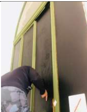
Instalação de película de proteção – Sala Expositiva 3
