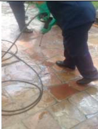
Lavagem – Piso do pátio lateral
