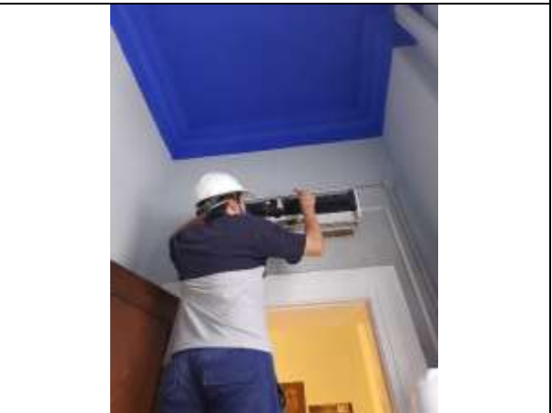
Manutenção Preventiva – Ar Condicionado (Mensal)
