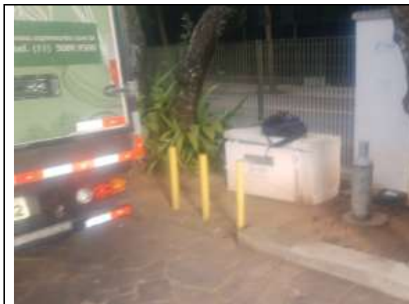
Teste de estanqueidade das tubulações de gás
