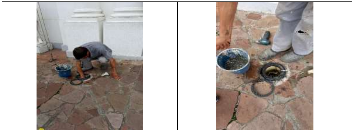
Manutenção das luminárias da fachada
