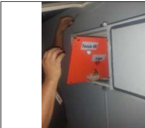
Substituição dos leds do painel de acionamento remoto
