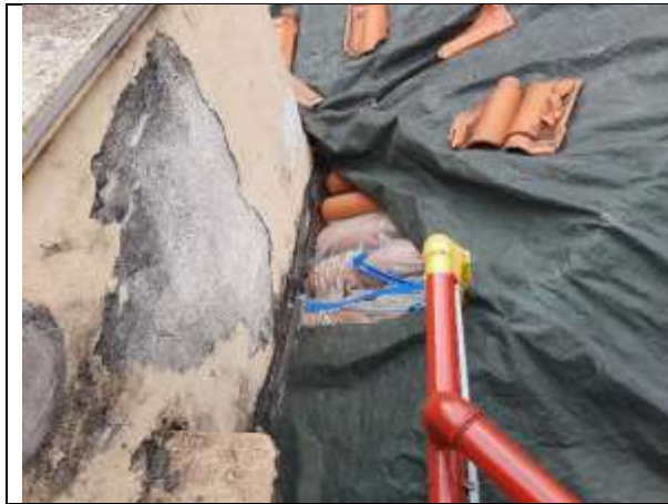
Manutenção corretiva das calhas e platibandas
