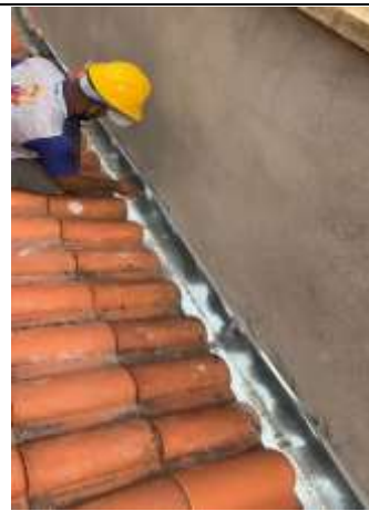
Manutenção corretiva das calhas e platibandas
