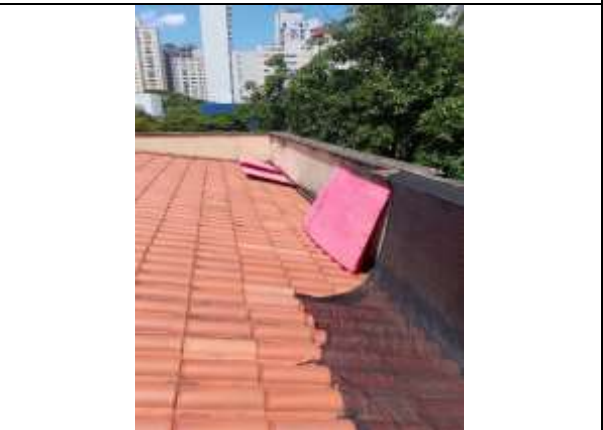
Manutenção corretiva das calhas e platibandas
