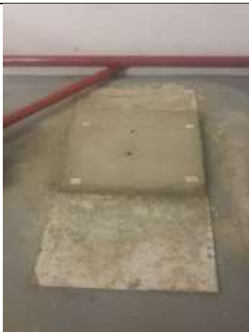
Confecção de nova tampa para o reservatório de água
