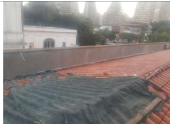
Manutenção corretiva das calhas e platibandas
