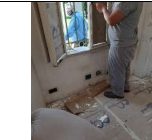
Pintura e recuperação – Guarita
