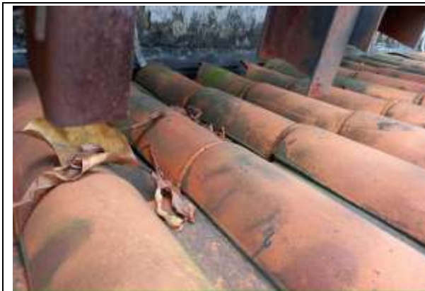
Retirada de folhas das calhas
