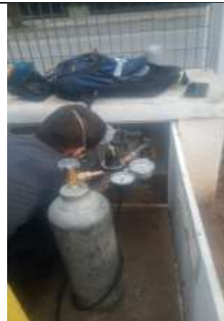
Teste de estanqueidade das tubulações de gás
