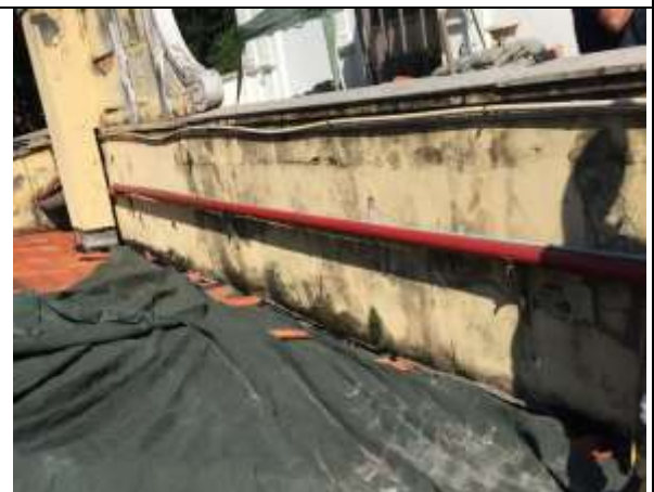
Manutenção corretiva das calhas e platibandas
