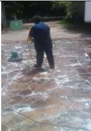
Lavagem – Piso do pátio lateral
