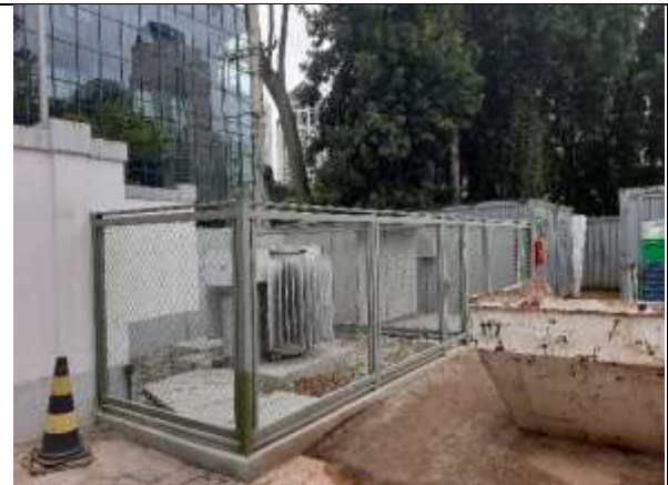
Limpeza da área destinada a Cabine primária
