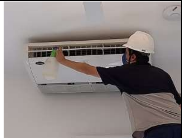
Manutenção Preventiva – Ar Condicionado (Mensal)
