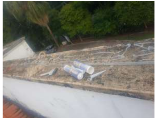
Aplicação de gel repelente contra pombos
