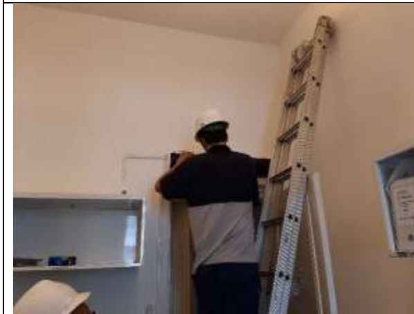
Manutenção Preventiva – Ar Condicionado (Mensal)
