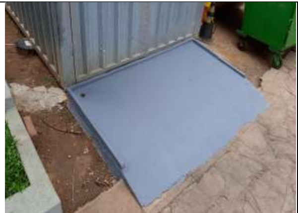
Pintura da base do contentor de resíduos orgânicos
