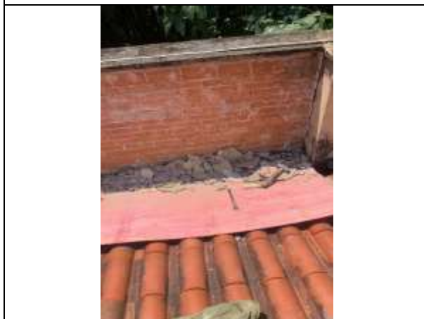
Manutenção corretiva das calhas e platibandas
