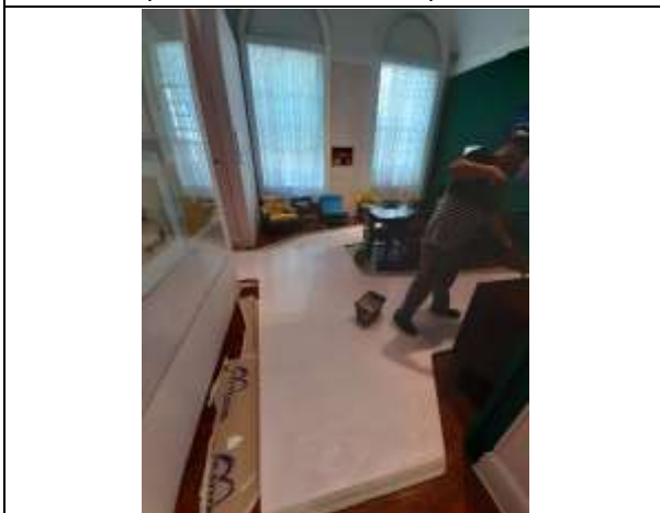
Pintura do piso elevado – Salas Expositivas 4 e 5
