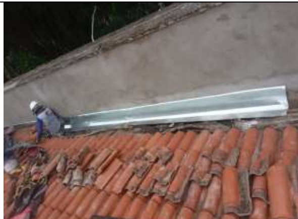
Manutenção corretiva das calhas e platibandas
