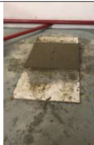
Confecção de nova tampa para o reservatório de água
