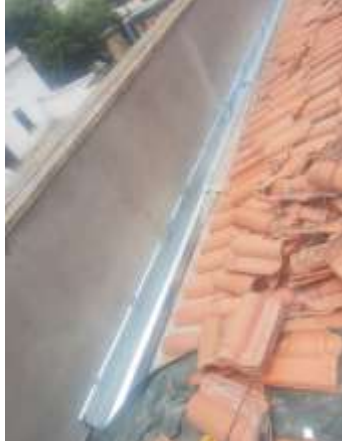
Manutenção corretiva das calhas e platibandas
