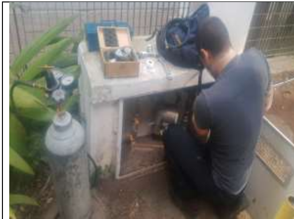
Teste de estanqueidade das tubulações de gás
