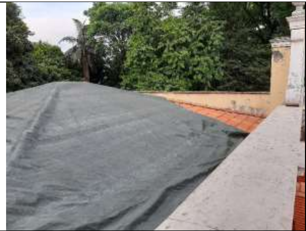
Manutenção corretiva das calhas e platibandas
