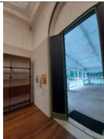
Instalação de película de proteção – Sala Expositiva 3
