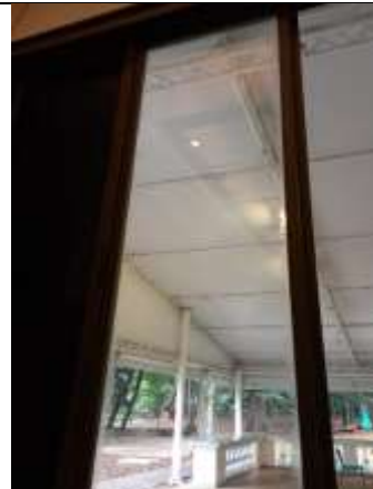
Substituição de vidros danificados
