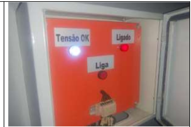
Substituição dos leds do painel de acionamento remoto
