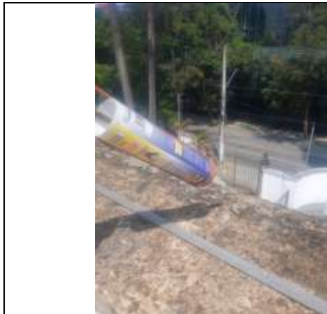
Aplicação de gel repelente contra pombos
