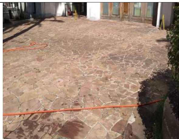
Lavagem rotineira do piso externo - Pátio lateral
