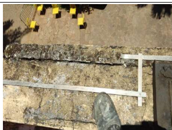
Ajustes no Sistema de Prevenção contra Descargas Atmosféricas (SPDA)
