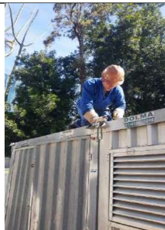
Instalação de container, adequação layout.
