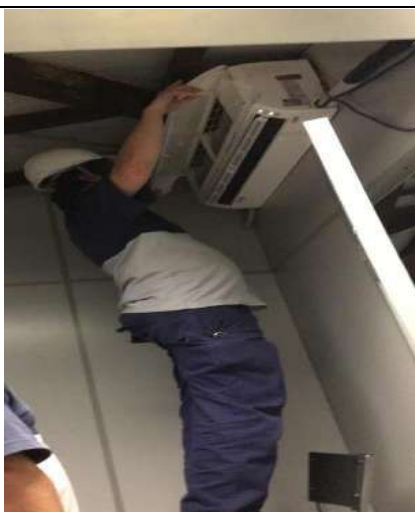
Manutenção Preventiva – Ar Condicionado (Mensal)
