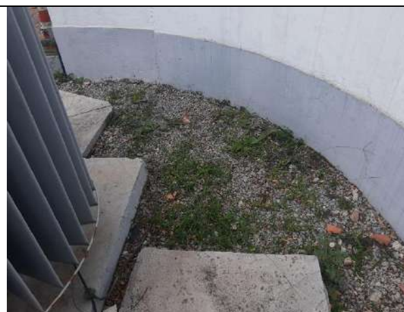
Limpeza rotineira da área destinada à Cabine Primária
