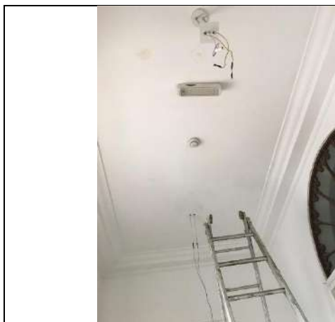
Instalação de Luminária – Hall Crespi Prado
