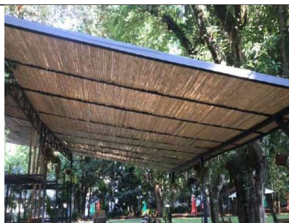
Instalação de forro de bambu e melhoria no deck do restaurante
