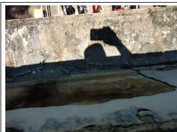
Ajustes no Sistema de Prevenção contra Descargas Atmosféricas (SPDA)
