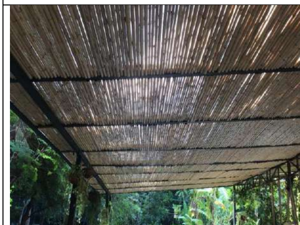
Instalação de forro de bambu e melhoria no deck do restaurante
