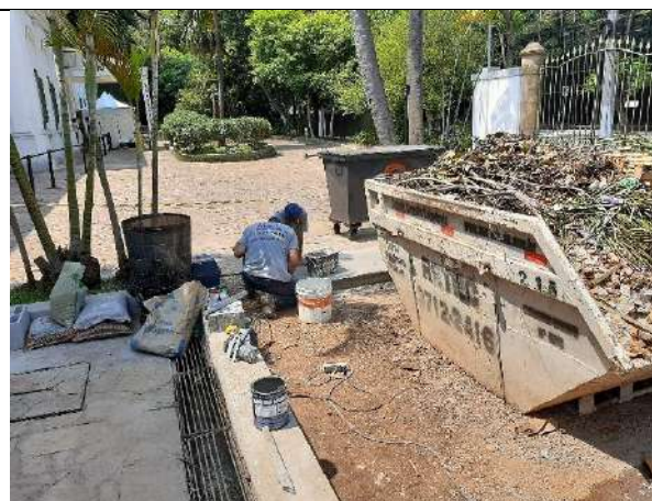
Adequação civil da área do container de resíduo orgânico
