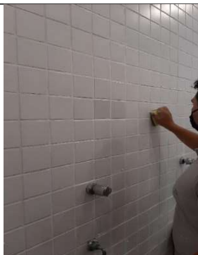
Renovação do rejunte da Copa de funcionários e Banheiro Masculino.
