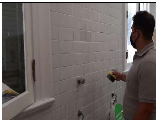
Renovação do rejunte da Copa de funcionários e Banheiro Masculino.
