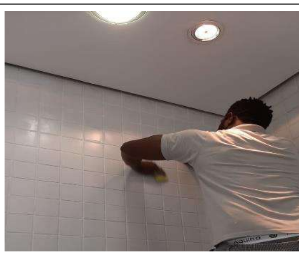
Renovação do rejunte da Copa de funcionários e Banheiro Masculino.
