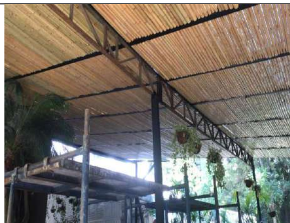
Instalação de forro de bambu do deck do restaurante e reforço na estrutura.
