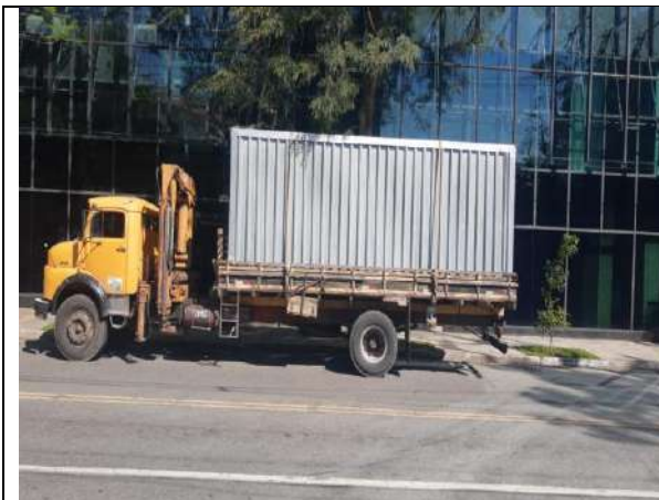
Instalação de container, adequação layout.
