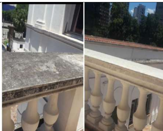
Lavagem rotineira do piso da cobertura - Crespi Prado
