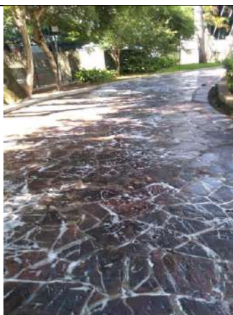
Lavagem rotineira do piso externo - Pátio lateral
