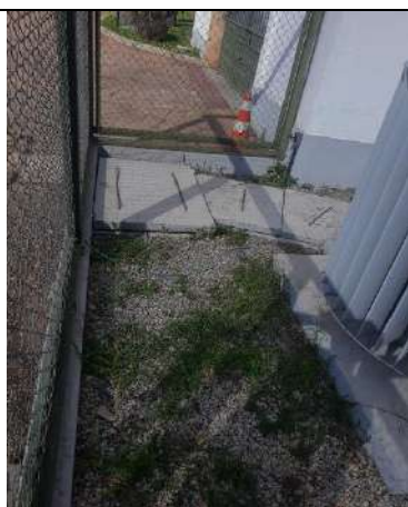
Limpeza rotineira da área destinada à Cabine Primária
