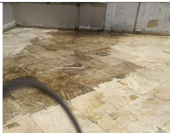
Lavagem rotineira do piso da cobertura - Crespi Prado
