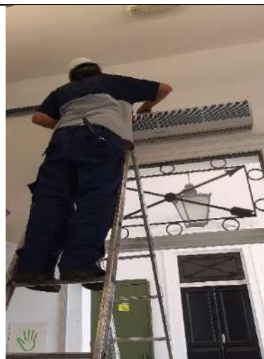
Manutenção Preventiva – Ar Condicionado (Mensal)
