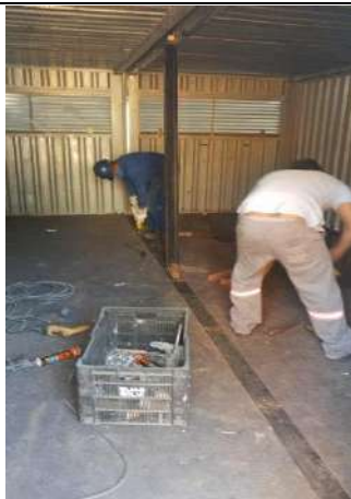
Instalação de container, adequação layout.
