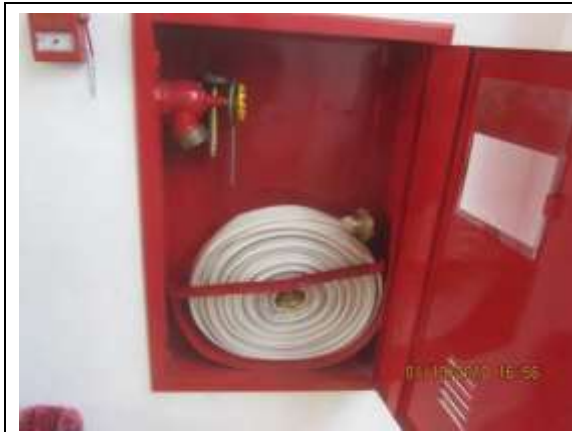
Substituição das mangueiras de hidrantes condenadas durante teste hidrostático (out)
