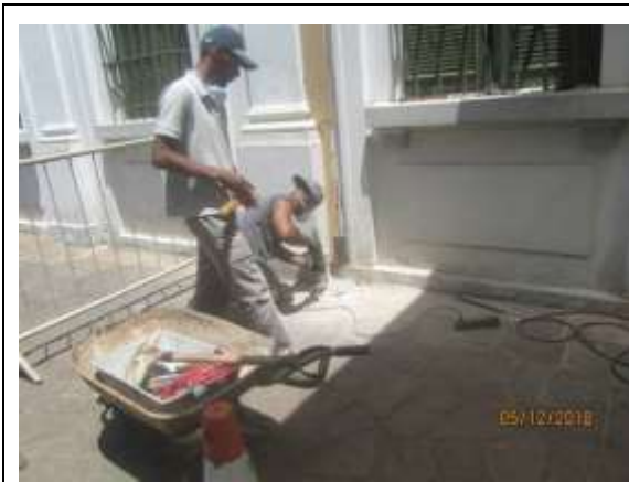
Abertura em piso para passagem de tubulação hidráulica para alimentação de bebedouro de pressão (dez)
