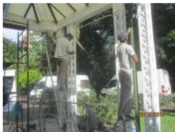
Pintura dos pilares da marquise lateral (dez)
