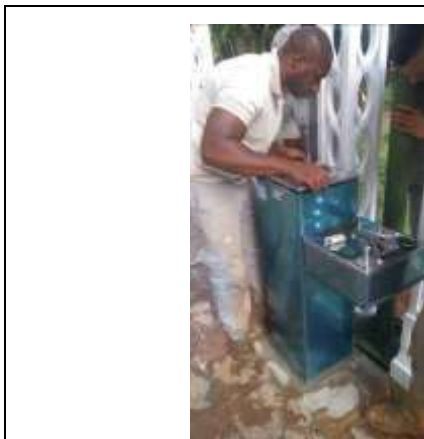
Instalação do Bebedouro (dez)
