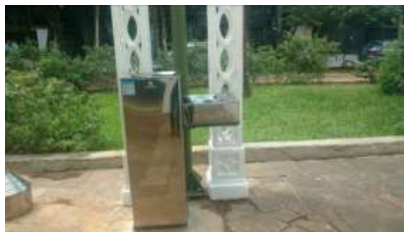
Instalação do Bebedouro (dez)
