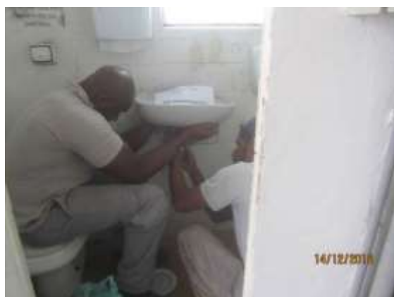
Manutenção sanitário guarita (dez)
