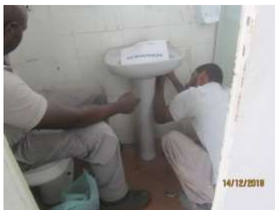
Manutenção sanitário guarita (dez)
