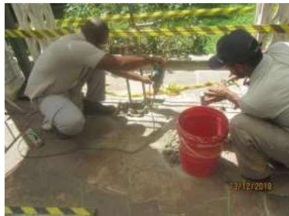
Abertura em piso para passagem de tubulação hidráulica para alimentação de bebedouro (dez)
