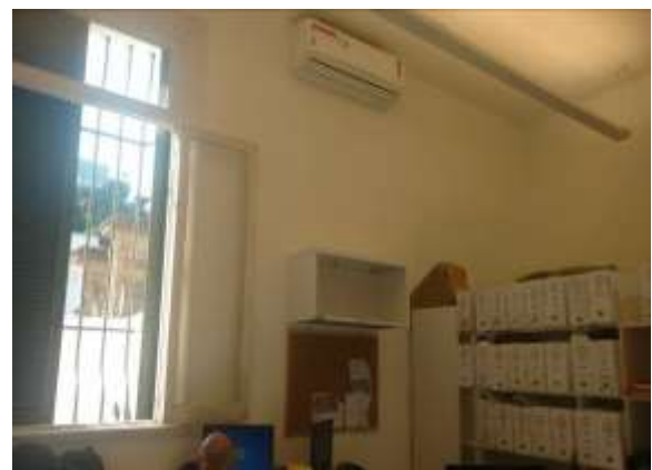
Pintura Sala ADM – Depois (out)
