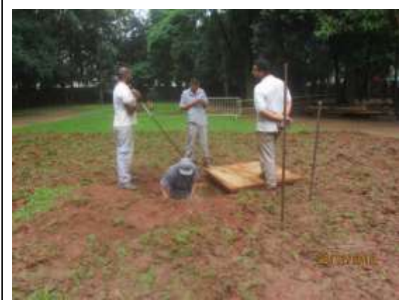
Manutenção das caixas de drenagem do jardim (dez)
