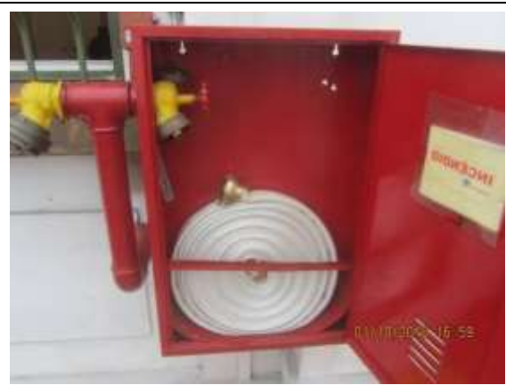
Substituição das mangueiras de hidrantes condenadas durante teste hidrostático (out)
