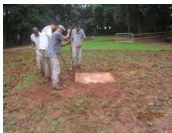
Manutenção das caixas de drenagem do jardim (dez)
