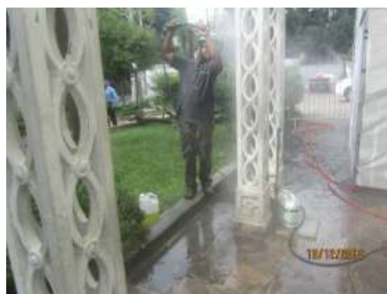
Lavação da marquise e pilares antes da instalação do bebedouro (dez)
