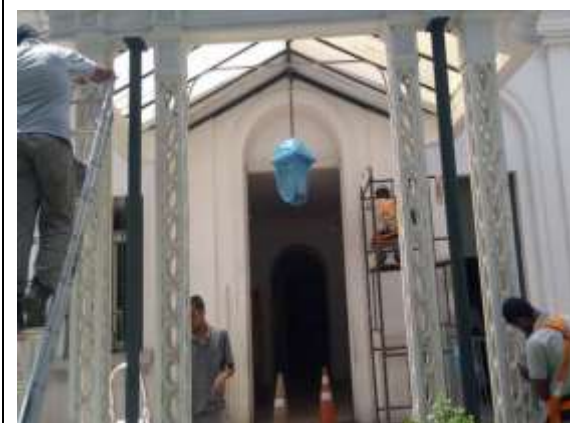
Pintura dos pilares da marquise lateral (dez)
