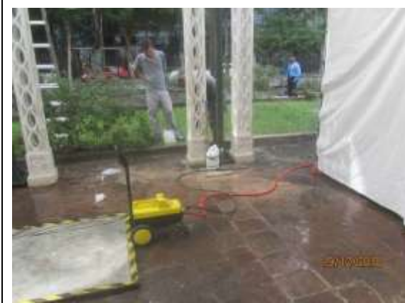
Lavação da marquise e pilares antes da instalação do bebedouro (dez)
