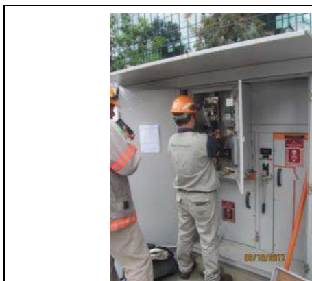
Manutenção da cabine primária pela AES Eletropaulo (out)
