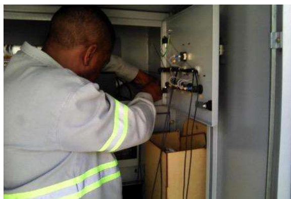
Instalação de sistema de acionamento remoto para a cabine primária (dez)
