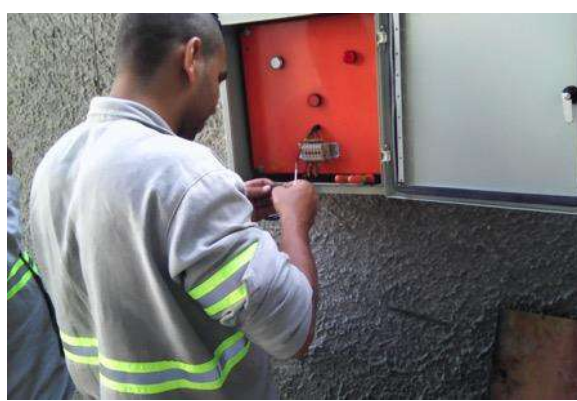
Instalação de sistema de acionamento remoto para a cabine primária (dez)
