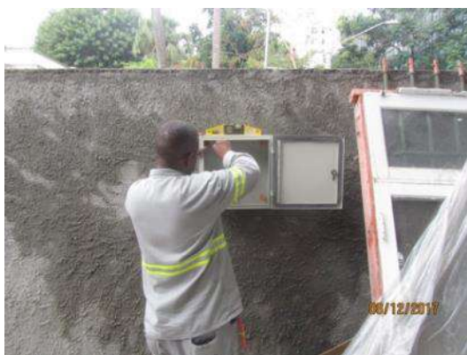
Instalação de sistema de acionamento remoto para a cabine primária (dez)
