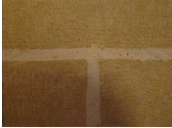
Imagem do detalhe dos frisos entre a argamassa.
