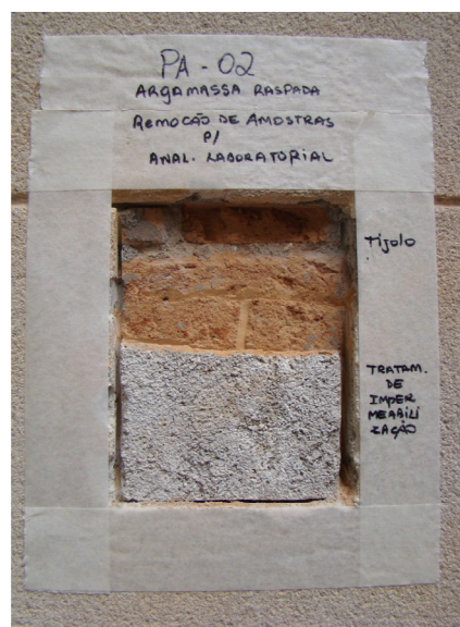
Prospecção revelando método construtivo e tratamentos.
