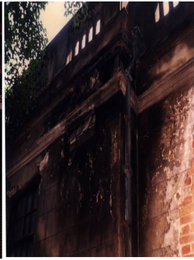
Situação das fachadas da edificação em 1987, antes das obras de restauro.
