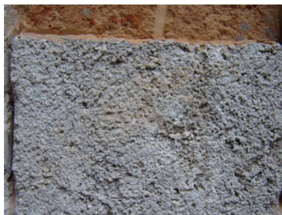
Detalhe da camada de impermeabilizante aplicada diretamente sobre os tijolos.
