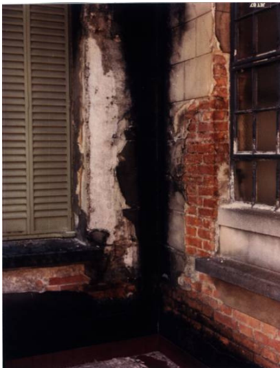
Situação do local da Prospecção Arquitetônica em 1987.
