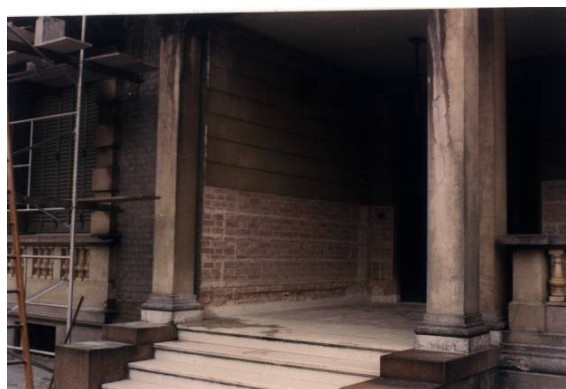
Imagem durante as obras de restauro mostra o revestimento removido, a impermeabilização e a nova argamassa raspada sendo executada.
