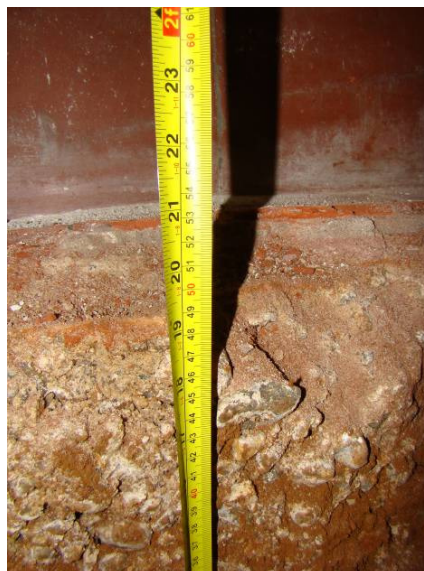
Prospecção Arquitetônica mostrando a profundidade de 47 cm de profundidade da sapata corrida de fundação
