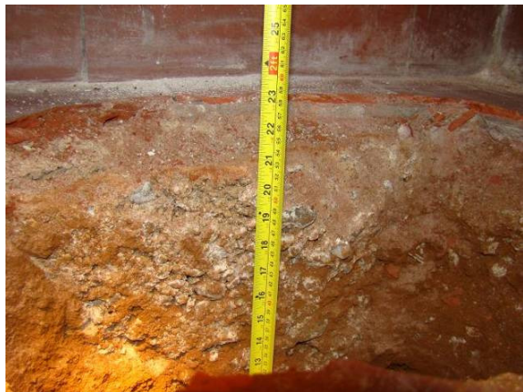
Prospecção Arquitetônica mostrando a profundidade de 47 cm de profundidade da sapata corrida de fundação
