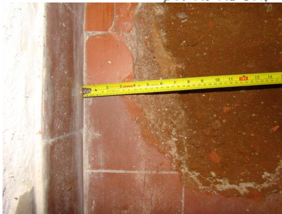
Prospecção Arquitetônica mostrando a largura do baldrame de 22 cm a partir da parede.
