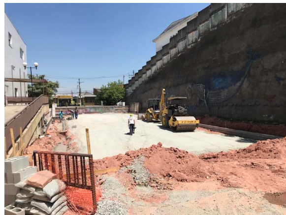
Terraplanagem e concretagem do piso da Arena de Apresentações da Fábrica Vila Nova Cachoeirinha.
