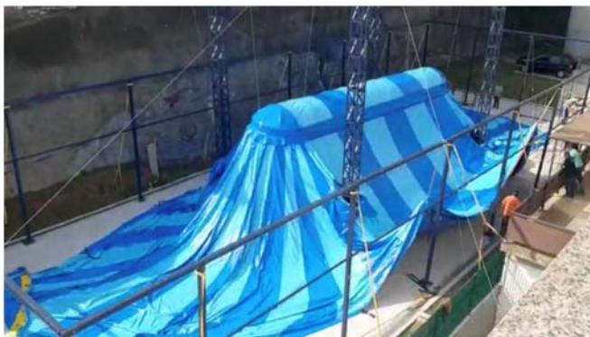
Montagem e amarração da lona da Arena Vila Nova Cachoeirinha
