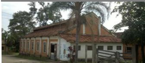
Pavilhão de oficinas. Foto: Adda Ungaretti, 2015.
