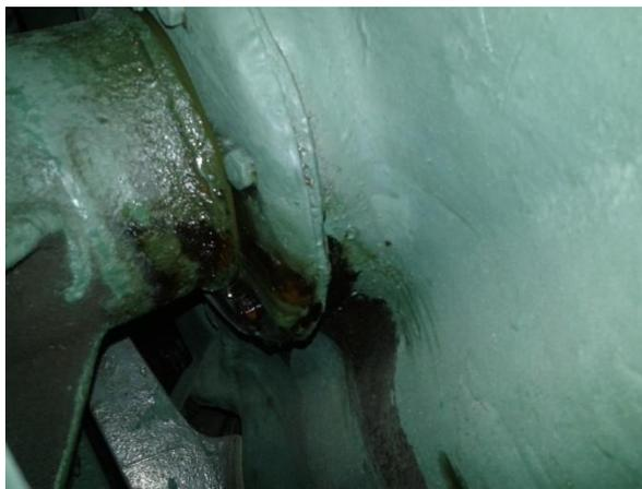
Troca da vedação do motor do elevador devido ao vazamento de óleo.
