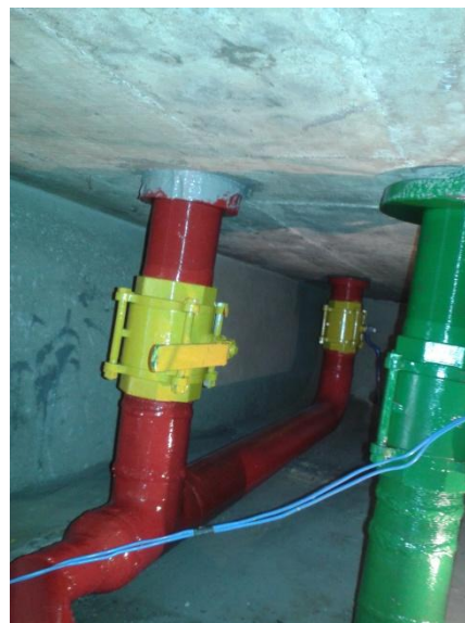
Sistema de saídas que permitem agora, manobras para utilizar uma ou as duas caixas simultaneamente.
