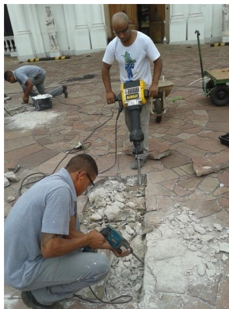
Quebra do contra piso
