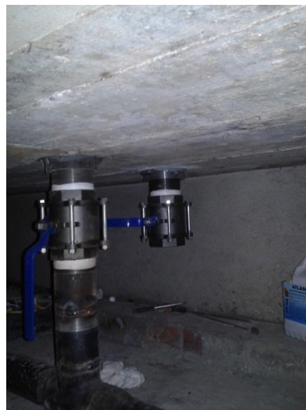
Válvulas esferas tripartidas, fácil manutenção e não emperram facilmente.
