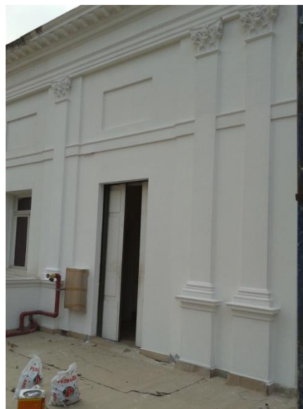
Fechamento e acabamento dos tubos dos drenos
