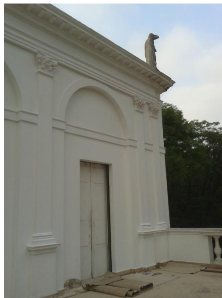
Pintura das paredes externas
