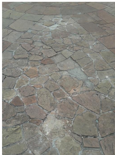
Desgastes por passagens de veículos e o tempo
