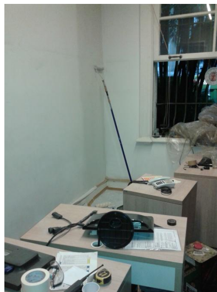
Pintura e adequação de rede, telefonia e elétrica
