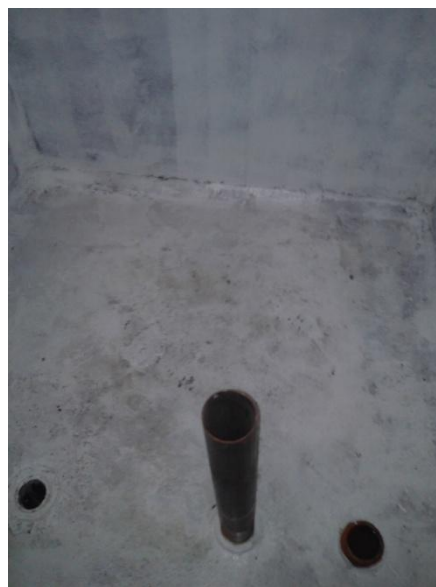
Tubo de saída para o consumo geral tem pescoço de 1 metro, deixando sempre uma reserva para hidrante
