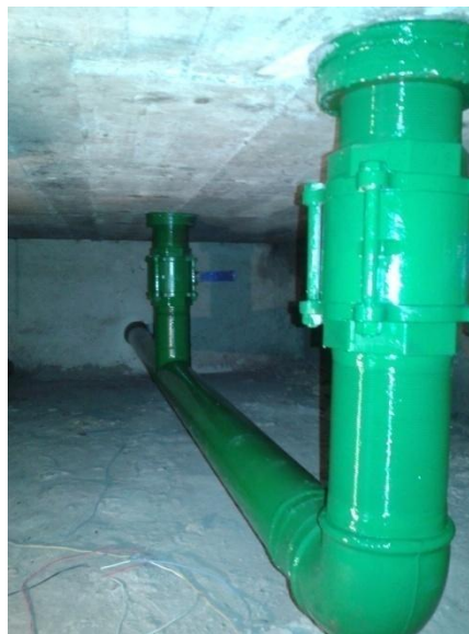
Troca de tubulações entupidas e danificadas
