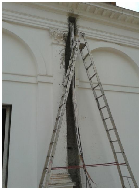
Passagem das tubulações
