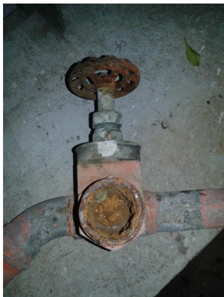
Válvula gaveta totalmente travada, tipo de válvula que facilmente emperra.
