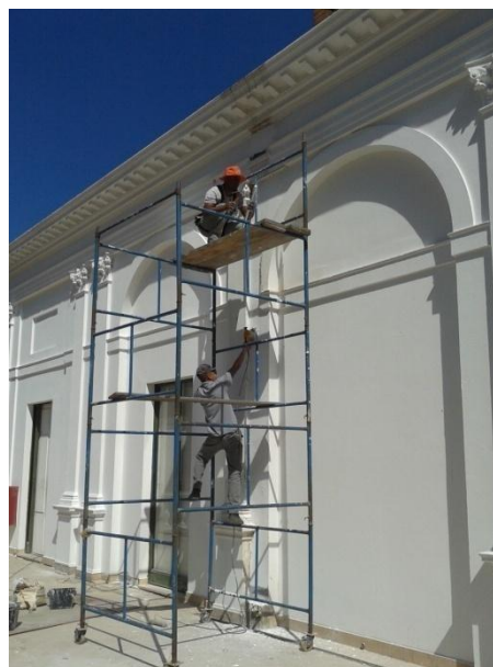
Acabamento e pintura
