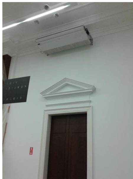
Instalação do 1º no CRESPI
