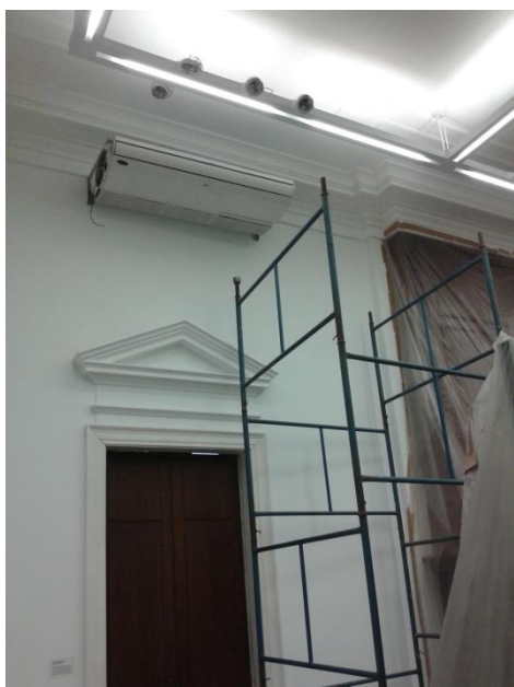
Instalação do 2º no CRESPI
