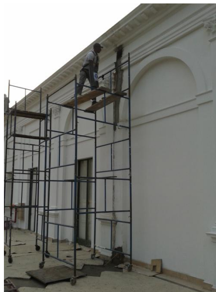
Fechamento da passagens das tubulações
