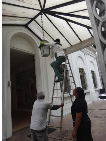
Limpeza da luminária da entrada lateral
