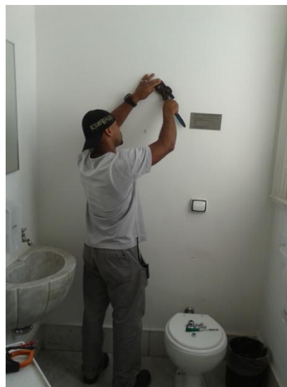
Reparos diversos - hidráulica
