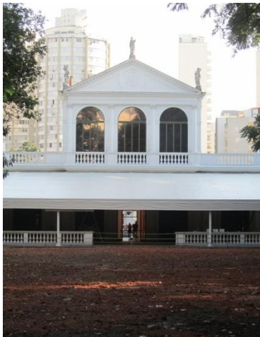
Troca do toldo do terraço: situação após a troca
