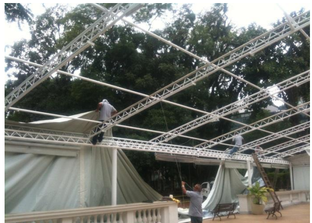
Troca do toldo do terraço: situação antes da troca
