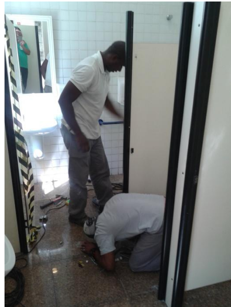
Fixação e reforço da divisória solta
