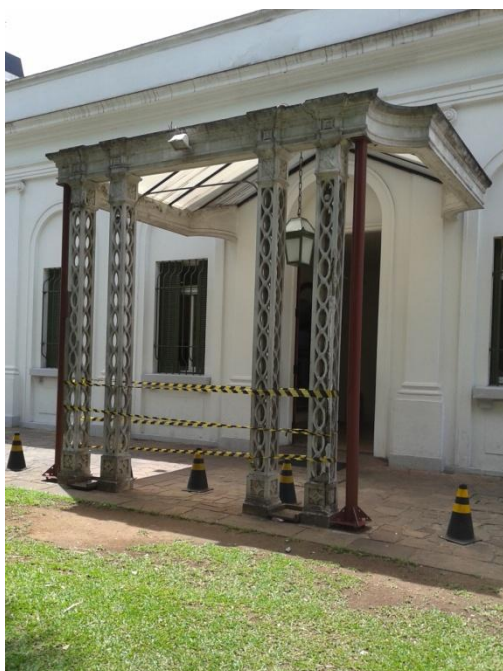
Instalação das colunas
