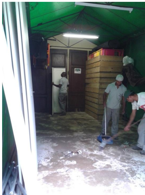
Retirada do material e limpeza
