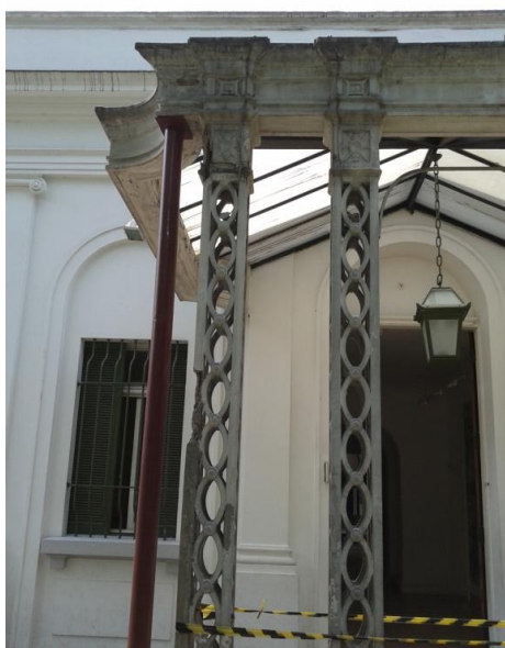
Alívio das colunas existentes com necessidade de recuperação
