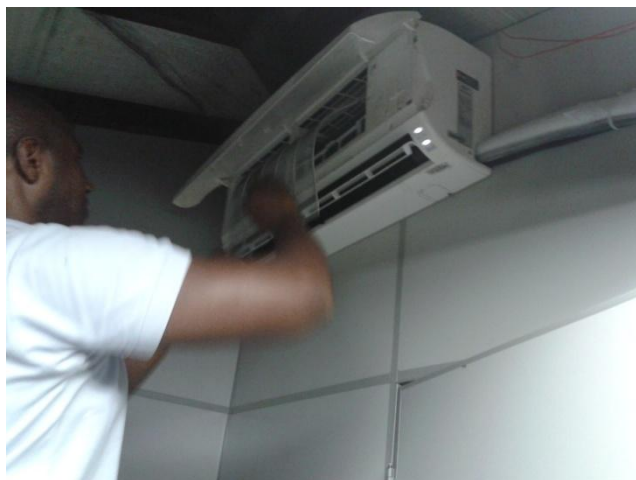
Manutenção e limpeza do ar condicionado da sala do servidor
