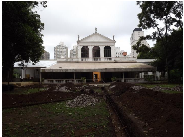
Troca do toldo do terraço: situação antes da troca
