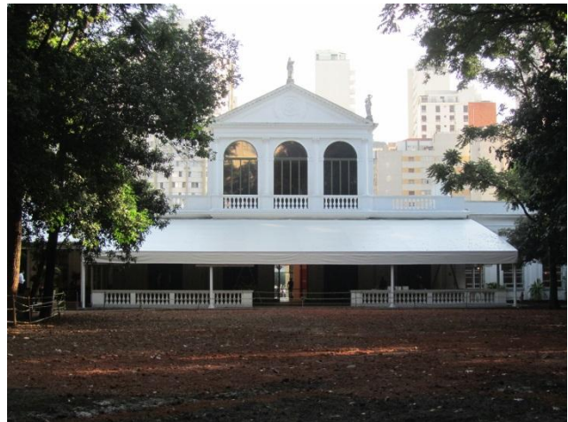
Troca do toldo do terraço: situação após a troca
