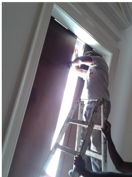
Recolocação das portas tratadas
