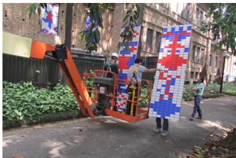
Montagem dos painéis nas janelas da fachada lateral do prédio da Pinacoteca.
