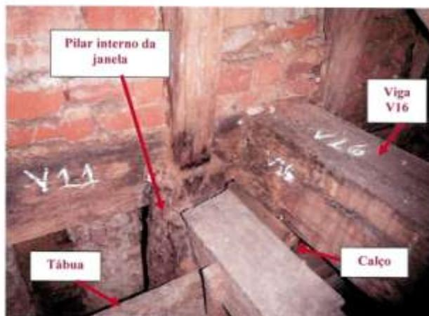
Figura 7: Apoio da viga V16 em tábua de madeira.
