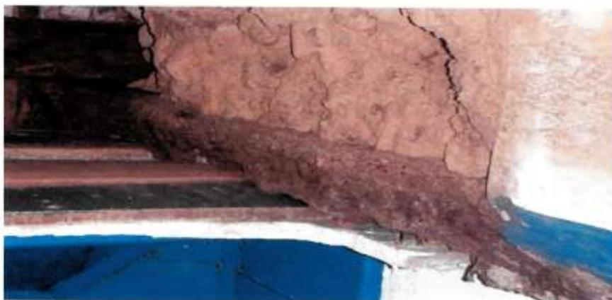
Figura 9: Detalhe do pilar interno da janela com elevado grau de biodeterioração.
