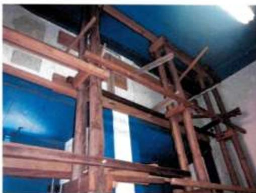
**Figura 10** – Escora de madeira construída com troncos e peças serradas, travadas horizontalmente e viga superior para sustentação do forro.
