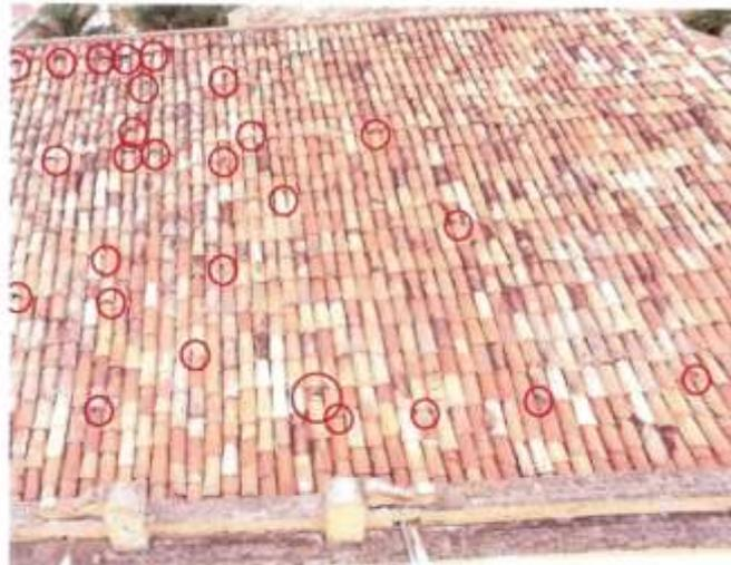
**Figura 13** – Ilustração de exemplos de pontos de falhas na água frontal do telhado do edifício. Observar o círculo vermelho de maior diâmetro que corresponde a ponto de maior importância quanto ao reparo.
