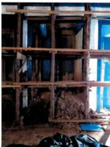
**Figura 3:** Detalhe da Figura 2. Taipa de pilão no piso do pavimento superior. A seta indica a posição da próxima figura.
