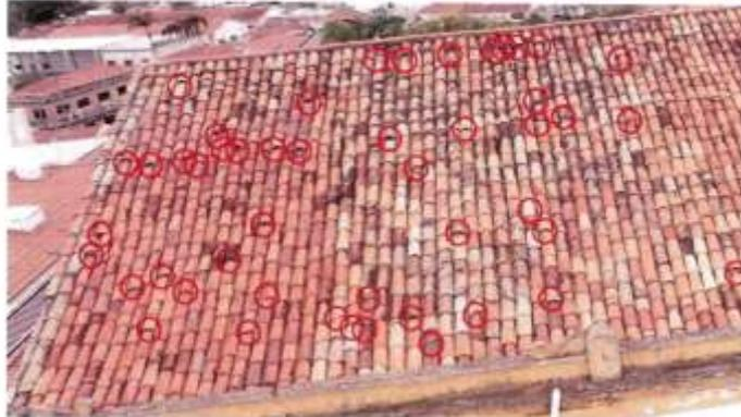
**Figura 12** – Ilustração de exemplos de pontos de falhas na água frontal do telhado do edifício.
