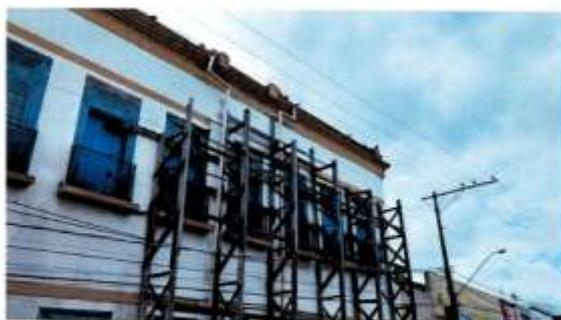
**Figura 11** – Escoramento de madeira construído com peças serradas unidas por pregos, contraventado horizontalmente apenas numa direção.
