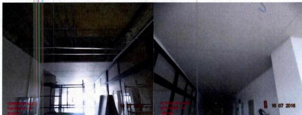
Forro dos corredores
