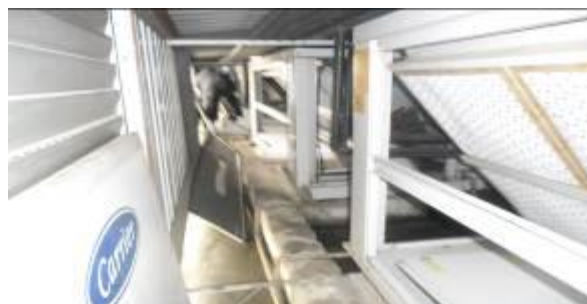
Foto 02 – MANUTENÇÃO PREVENTIVA DO AR CONDICIONADO
