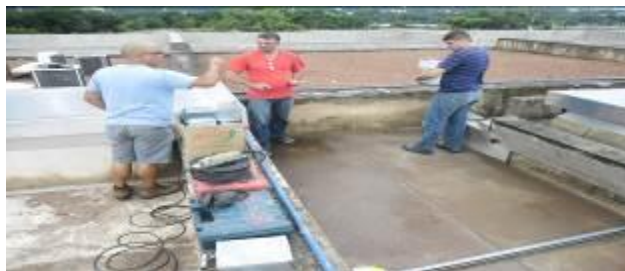
Foto 07 – INSTALAÇÃO DE CAIXAS DE PROTEÇÃO NO SISTEMA DE DRENAGEM DA LAJE
