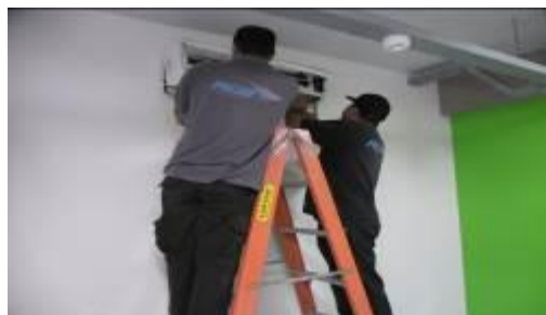
Foto 04 – MANUTENÇÃO PREVENTIVA DO AR CONDICIONADO
